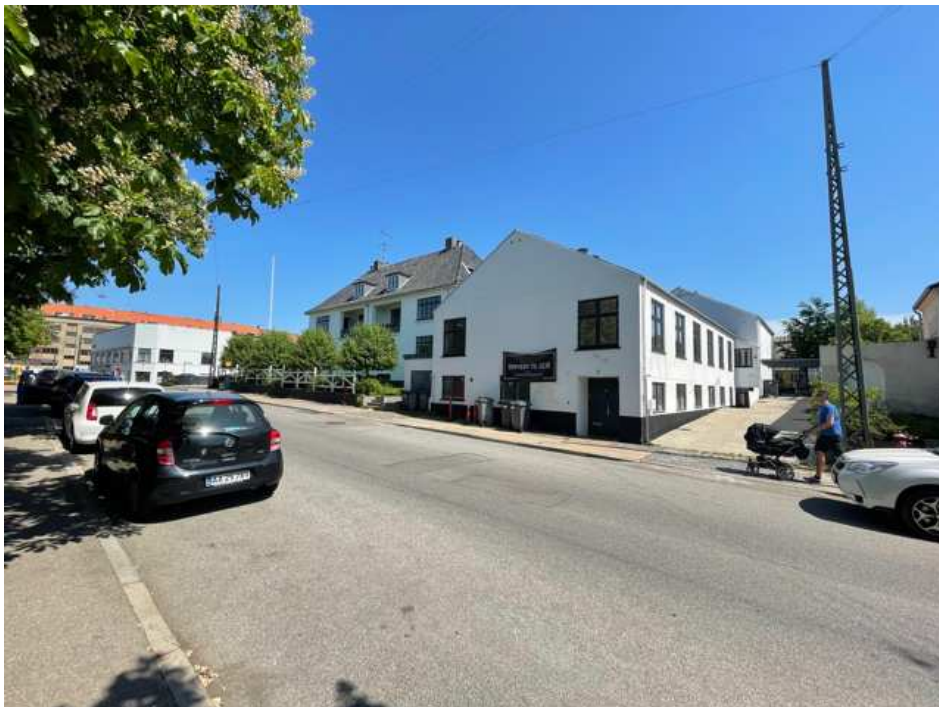
Krabbesholmvej 9 i midten med Krabbesholmvej 5-7 til venstre. Bygningerne orienterer sig mod Brønshøj Torv.
