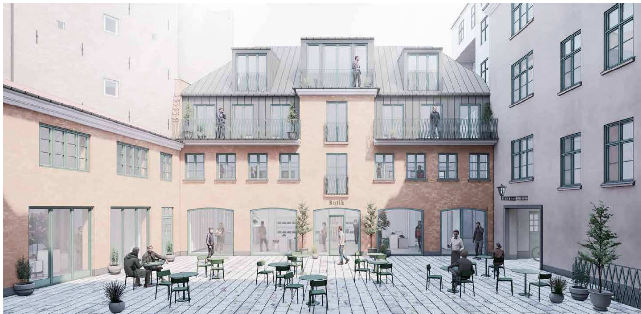
Sidehus ombygges med ny åben stueplan og ny tagetage
