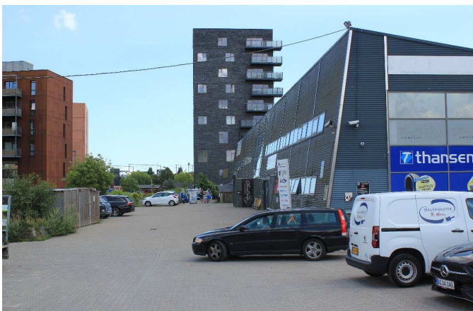
Lokalplanområdet set mod øst den eksisterende erhvervsbebyggelse, der nedrives. I baggrunden boligbebyggelser ved Følager og Poppelstykke.
