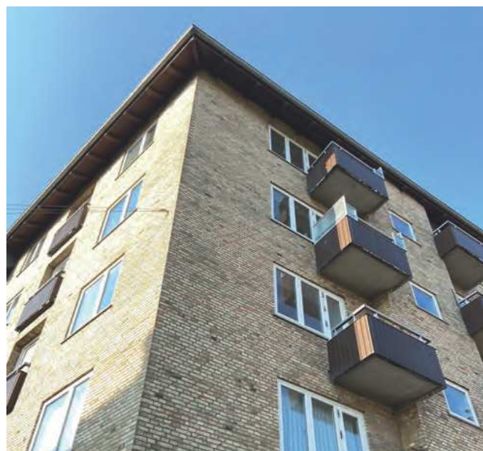
Brandsikring udføres blandt andet ved tagfod
