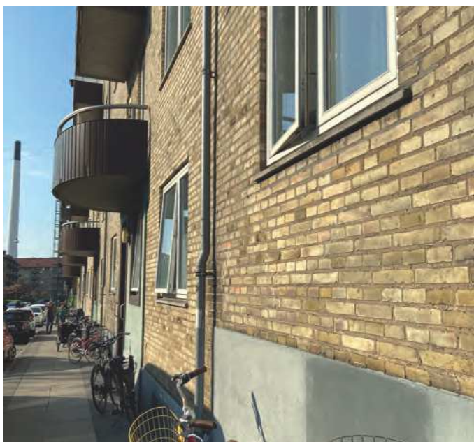
Vinduesbrystninger efterisoleres
