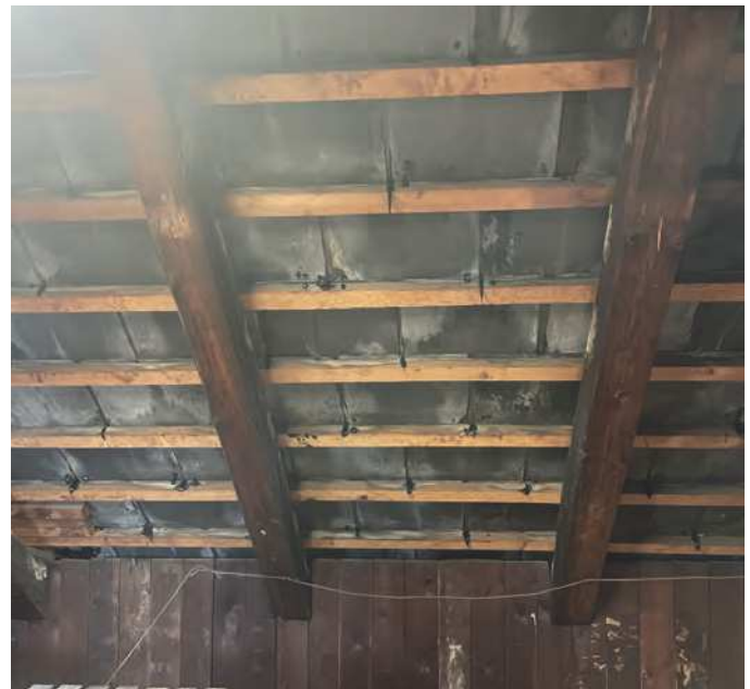
Der efterisoleres og etableres undertag
