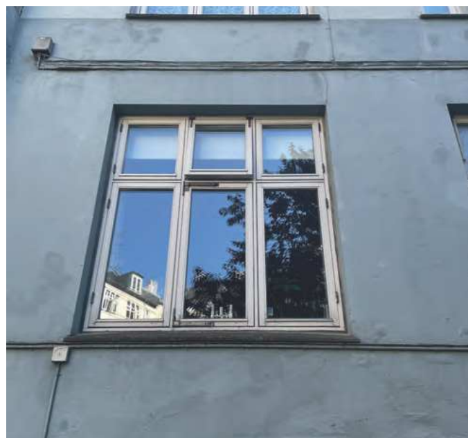
Ejendommens vinduer udskiftes, primært på gårdfacade
