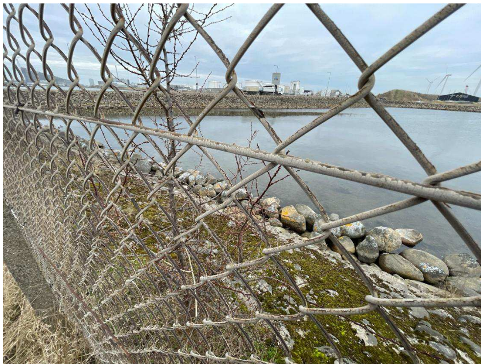
Figur 4-9 Stensætningen mod Prøvestenskanalen kan passeres af grønbroget tudse, marts 2026.
