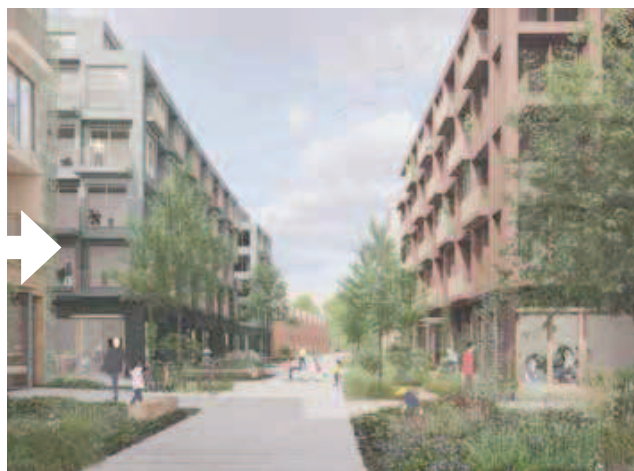
Gesims kun mellem stueetagen og 2. etage
