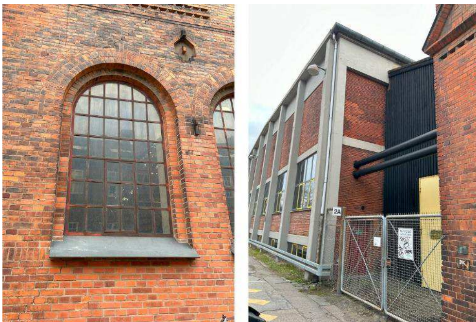
Figur 5-113 Tv. Facadedetalje og th. sammenbygning med Eftersynshallen. Foto COWI.
