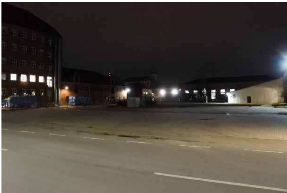
Figur 12-3 Belysning på eksisterende bygninger. (Foto: COWI).
