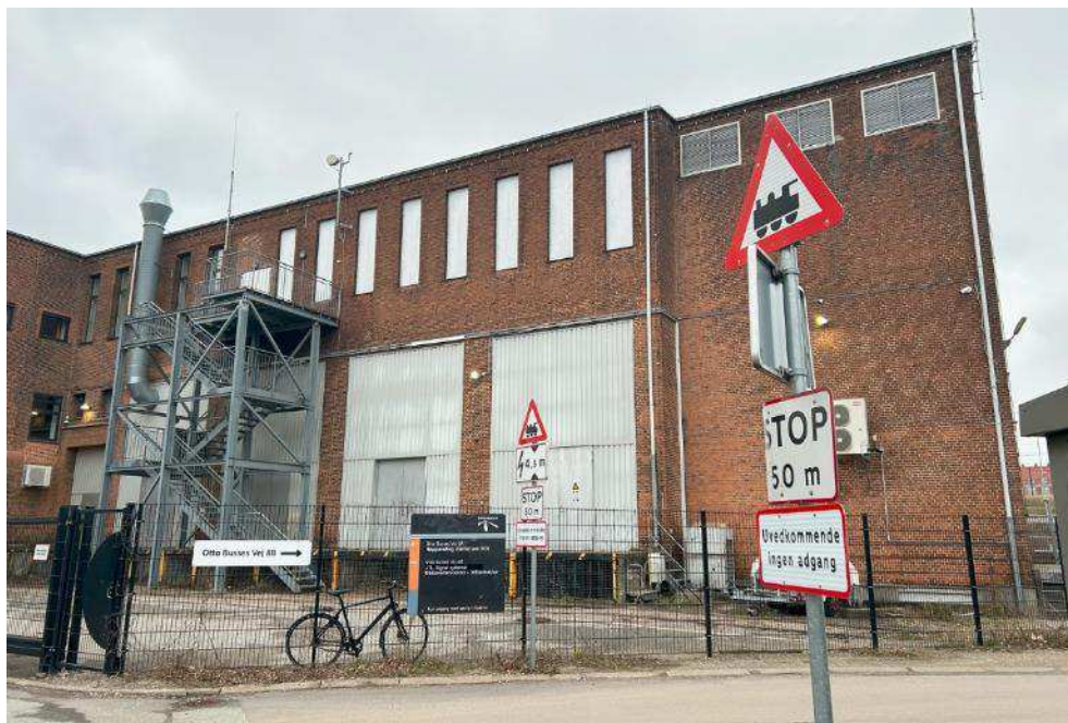
Figur 5-19 Omformerstationen set fra sydøst. Foto COWI 2024.
