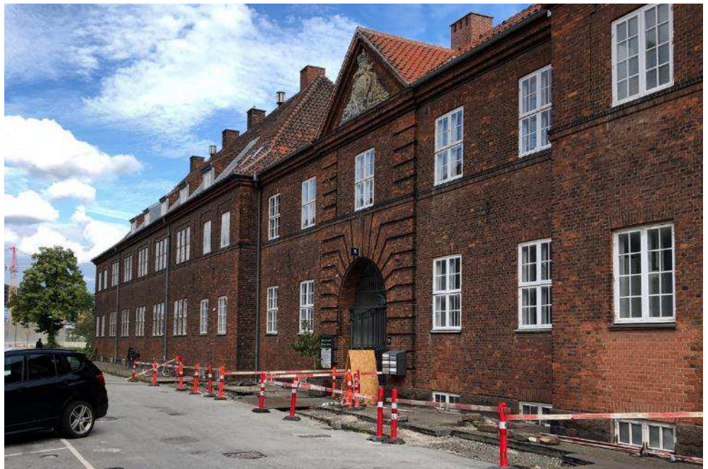
Figur 5-128 Nordfacade på Kontor- og administrationsbygningen. Foto Cobe.
