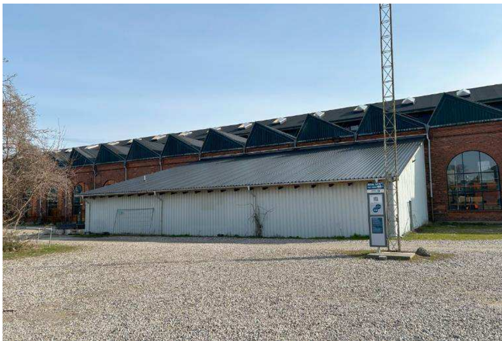
Figur 5-89 Påbygning på Lokomotivværkstedets facade, set fra vest, som kan fjernes. Påbygningen vender ud mod den centrale plads. Foto COBE.
