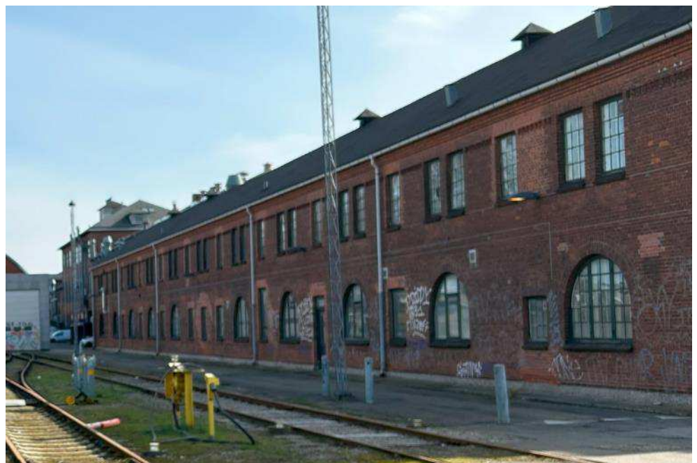
Figur 5-22 Vognværkstedets nordligste facade set fra vest. Foto COWI 2024.
