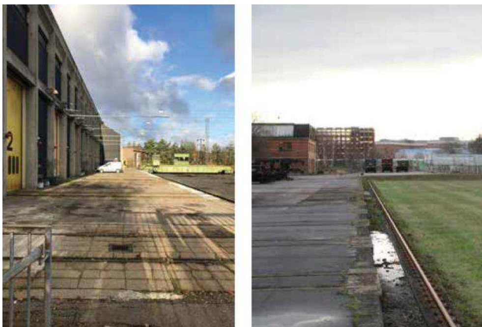
Figur 6-10 Illustrationen viser spor i industrielle anlæg – i sammenhæng med skydebroen og de gule porte på Ny eftersynshal. Foto Cobe.
