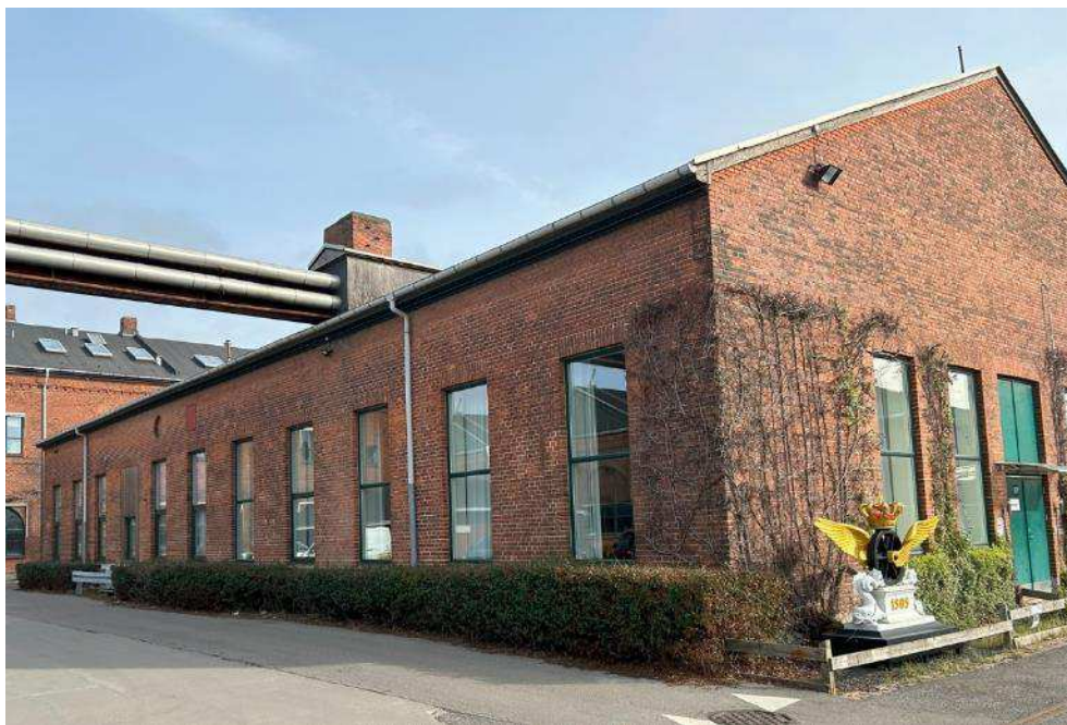
Figur 5-54 Trykløftværksted set fra syd. Foto Cobe.
