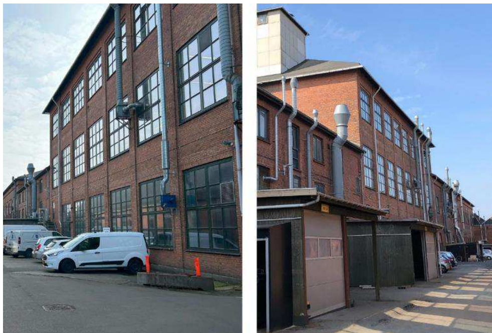
Figur 5-40 Ny elektrisk værksted. Foto Cobe.
