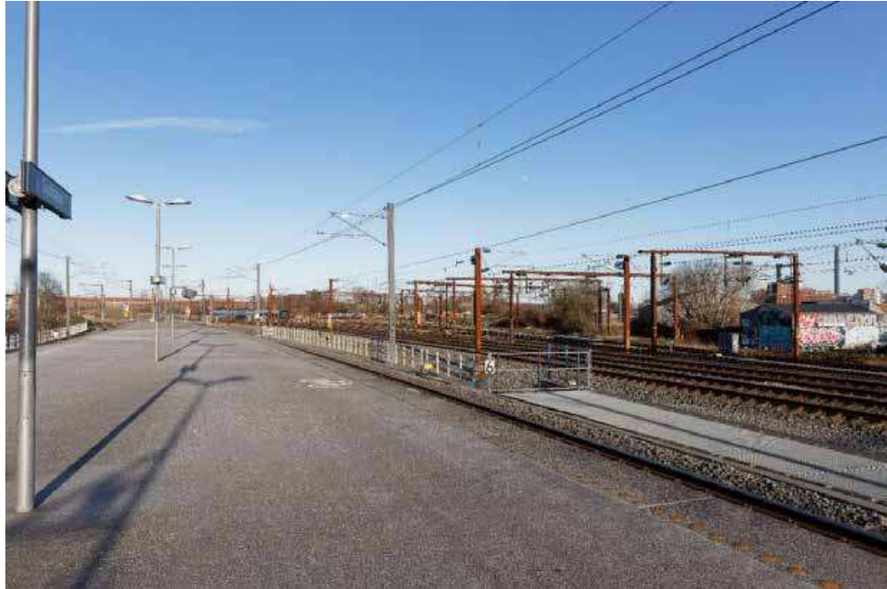
Figur 7-23 Punkt 10a – Sydhavn Station. Eksisterende forhold. (COWI).
