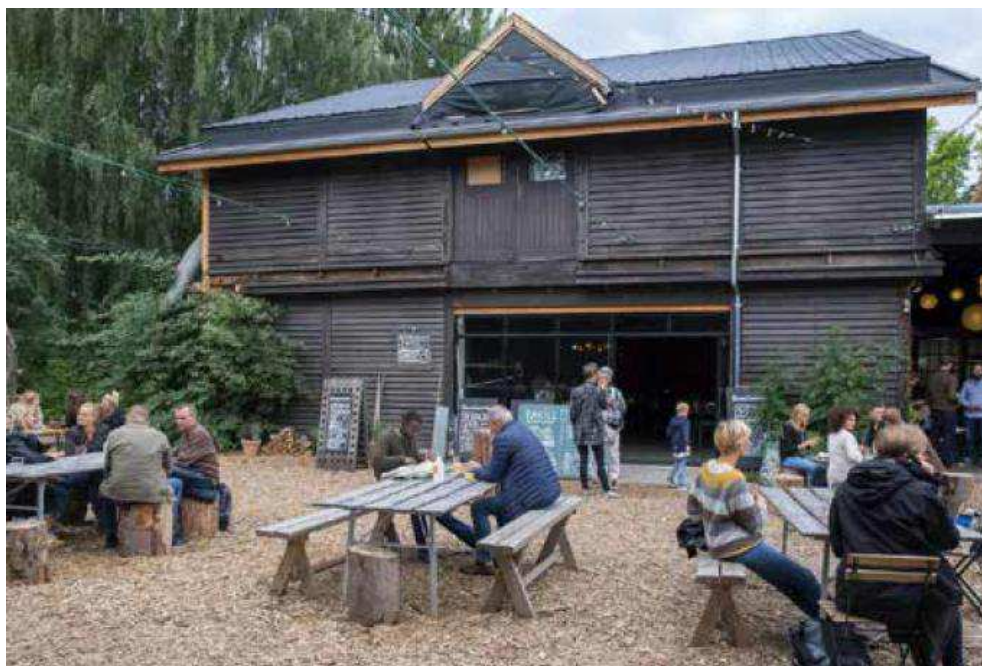
Figur 5-3 En af bygningerne som, sammen med otte tilsvarende bygninger, udgør Trælageret. Foto Bjarke Ørsted.
