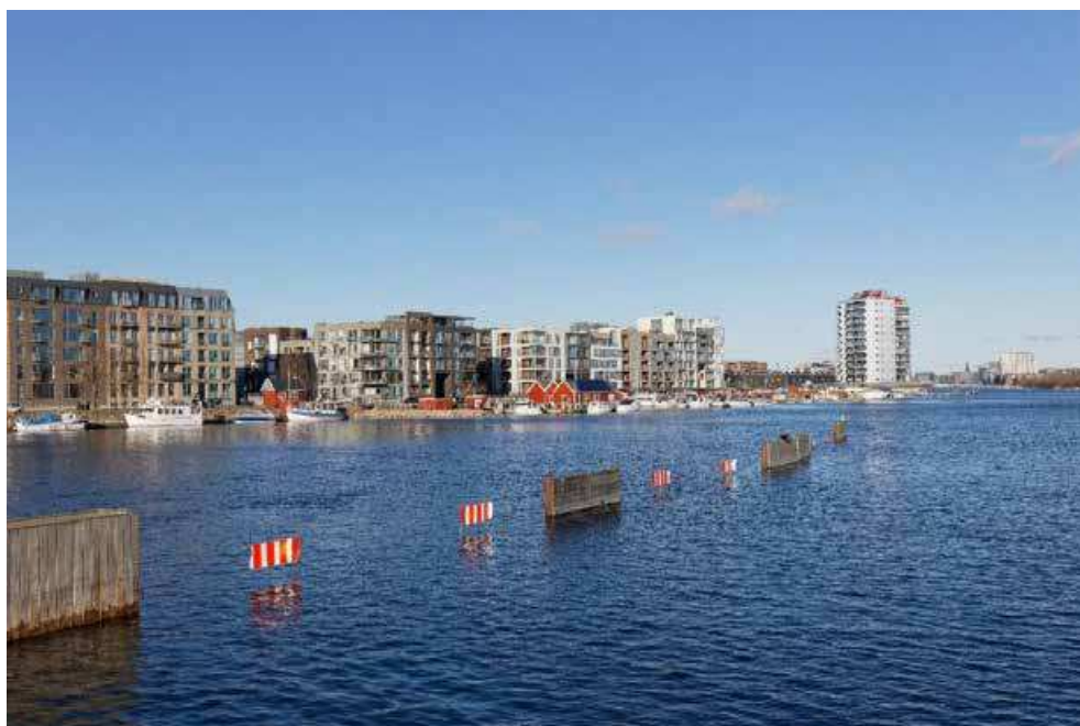
Figur 7-17 Punkt 7 – Slusen. Eksisterende forhold (COWI).
