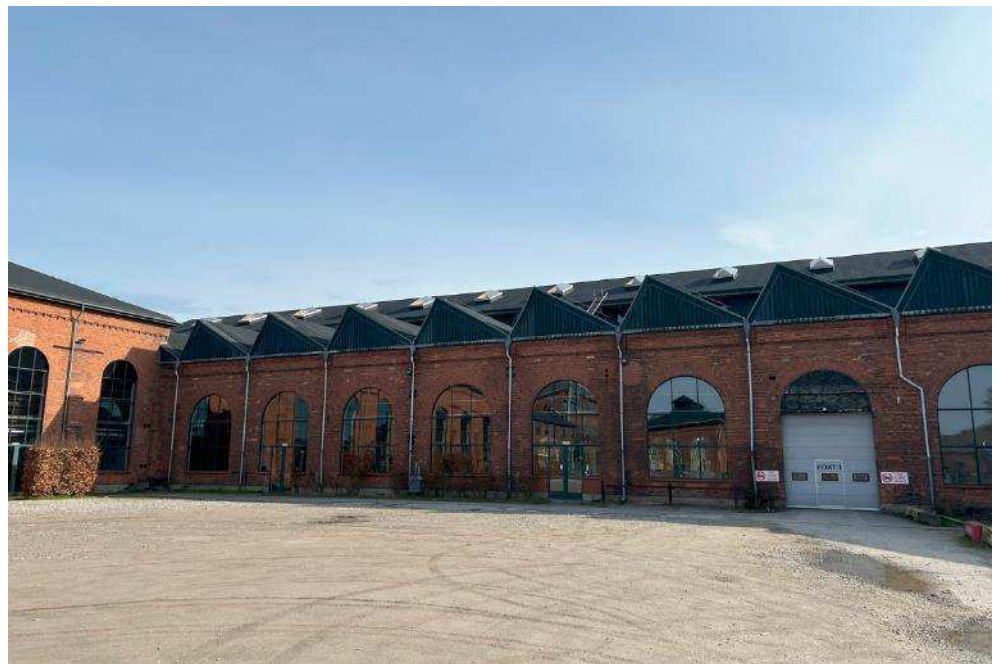
Figur 5-88 Lokomotivværkstedets facade set fra vest. Foto COWI.
