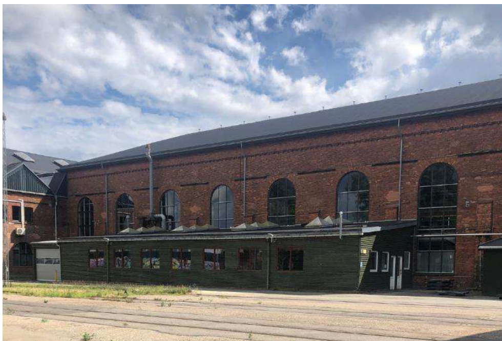
Figur 5-50 Plade- og kedelsmedjens facade set fra nord. Billedet viser en tilføjet træbygning, som bliver fjernet. Foto Cobe.
