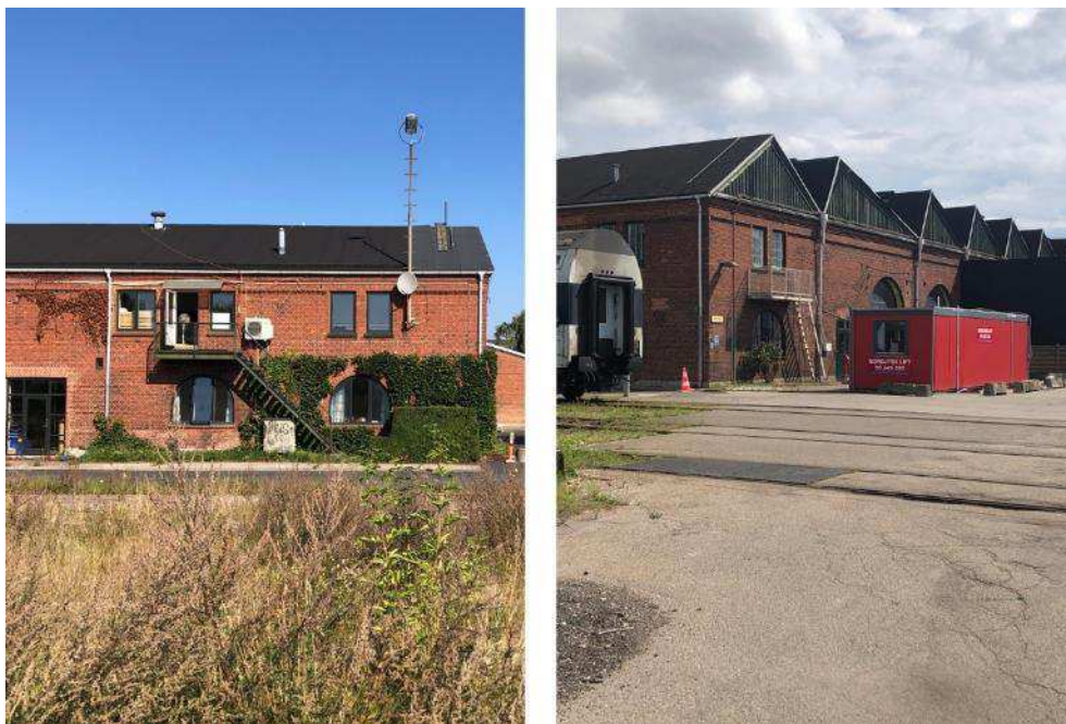
Figur 5-23 Tv. Vognværkstedets sydvestlige facade, set fra vest. Th. Vognværkstedets nordvestlige hjørne set fra vest. Foto Cobe 2023.
