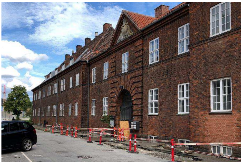
Figur 5-128 Nordfacade på Kontor- og administrationsbygningen. Foto Cobe.
