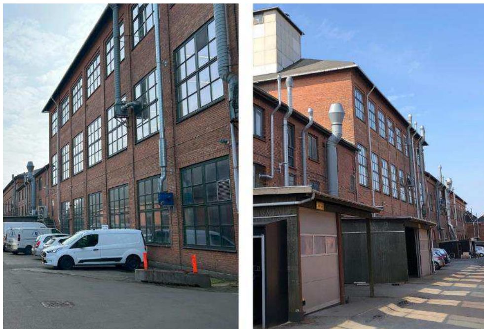
Figur 5-40 Ny elektrisk værksted. Foto Cobe.
