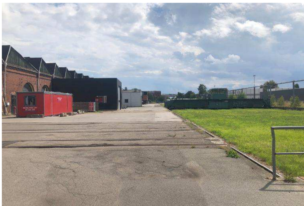
Figur 6-15 Skydebroanlæg set fra nord. Vognværkstedet ses til venstre i billedet. Foto Cobe.
