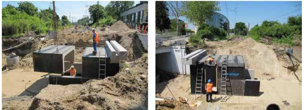
Figur 4-29 Eksempel på præfabrikerede elementer ved bro ved Gl. Bagsværdvej. (Foto: COWI).
