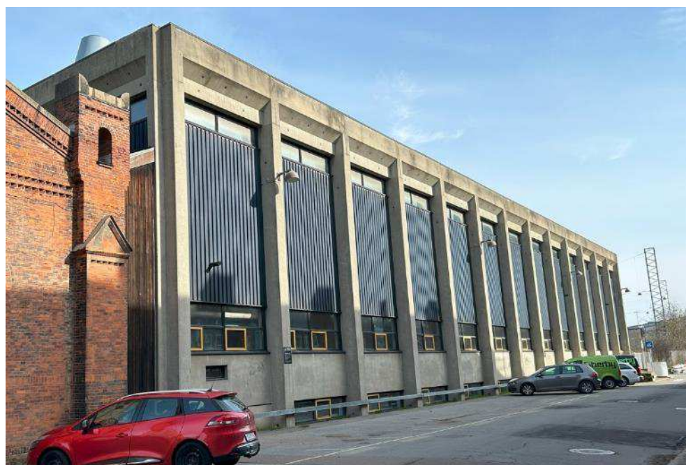
Figur 5-119 Ny eftersynshal set fra syd. Foto COWI.
