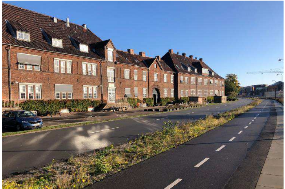
Figur 5-127 Kontor- og administrationsbygning set fra sydvest mod øst. Foto Cobe.
