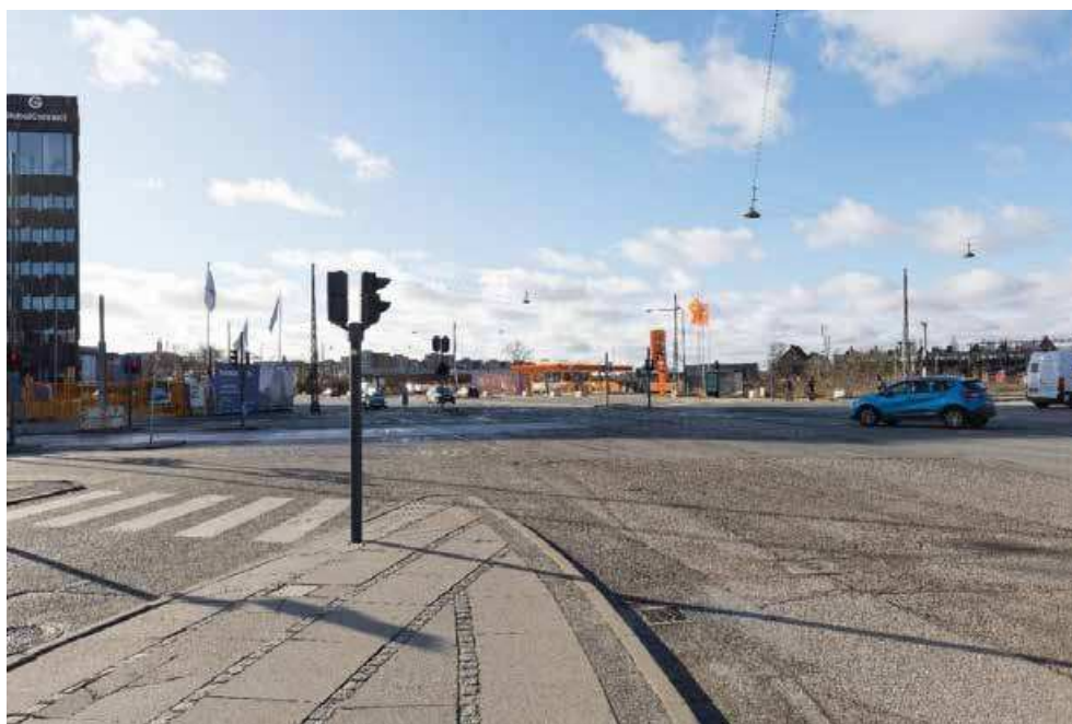
Figur 7-11 Punkt 4 – Havneholmen Metrostation. Eksisterende forhold. (COWI).
