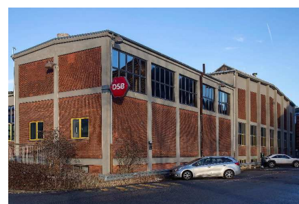
19. og 20. Værksted og Eftersynshal.
