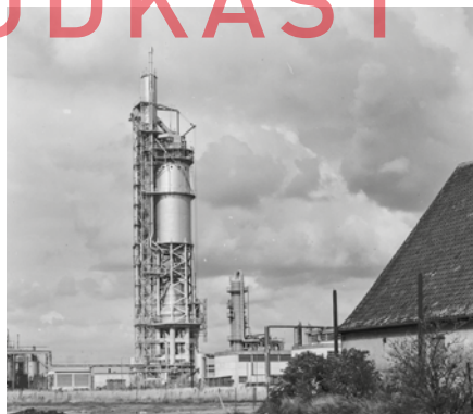
PYROLYSEVÆRKET MED KRUDTHUSET I FORGRUNDEN, 1965.
