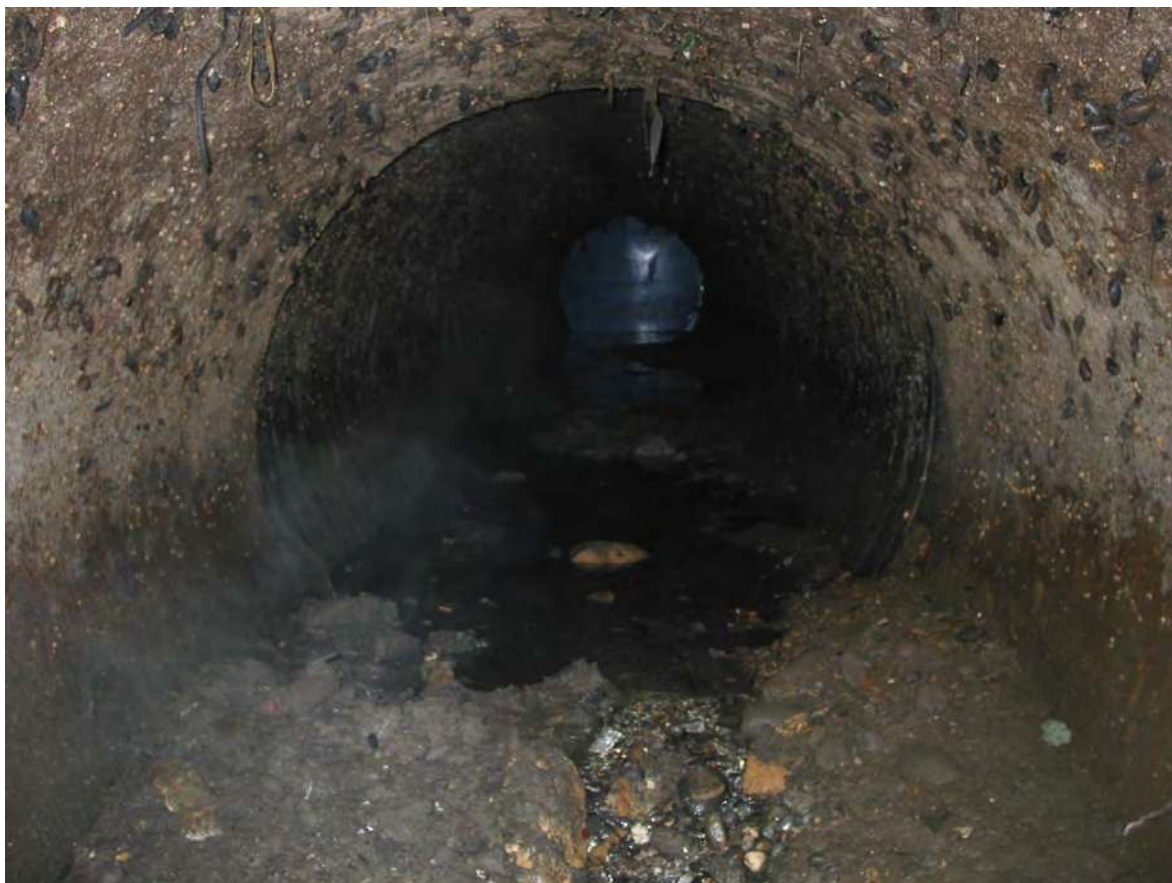
Foto 4 Fornyelsesmoden ledning
