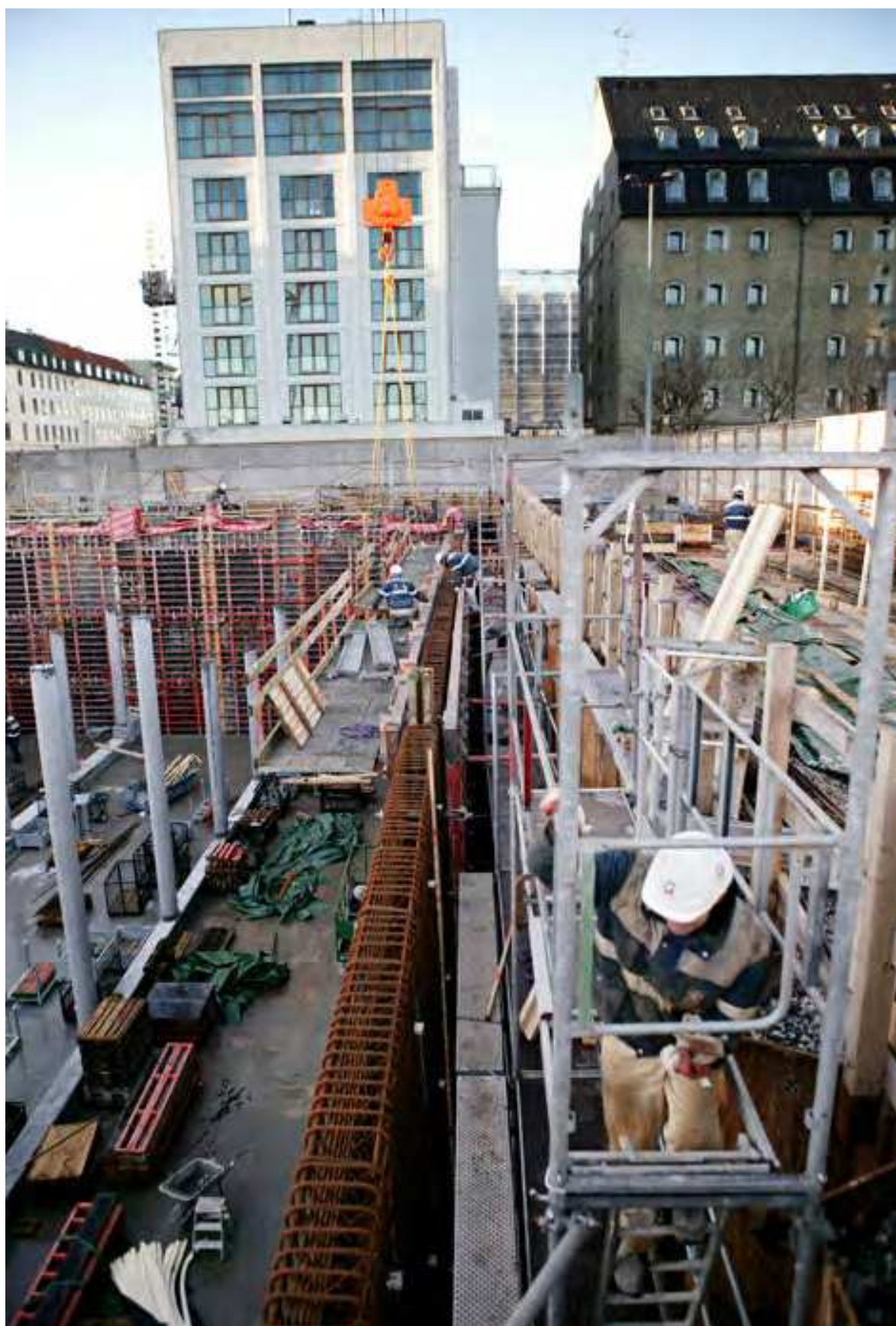
Foto 13 Komplekse anlægsarbejder ved Sankt Annæ Plads
