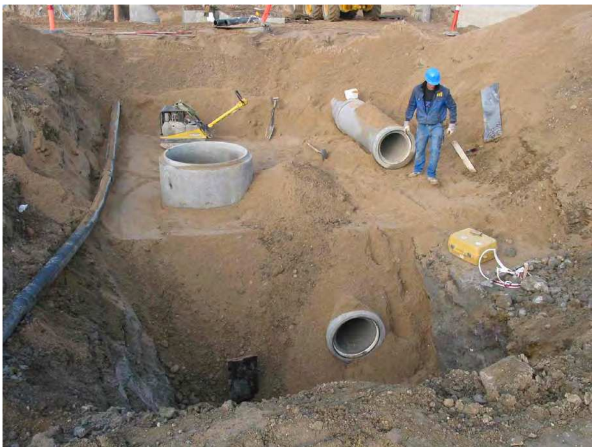
Foto 1 Nykloakering. Der anlægges både spildevandsledning og regnvandsledning
