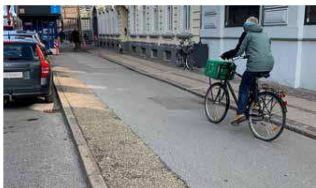
Sikkerhedszone med afvigende belægning, Niels Juels Gade
