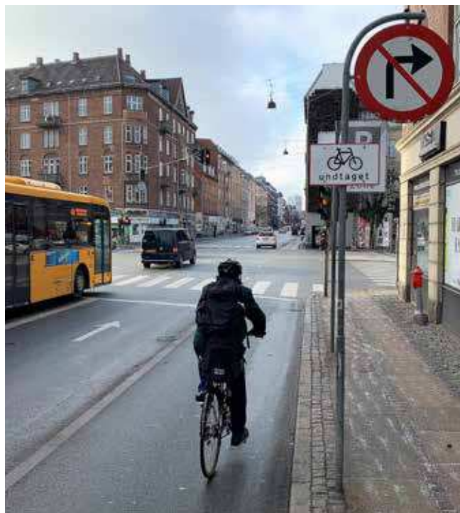
Fremført cykelsti og højresvingsforbud for bilister, Jagtvej/Ågade
