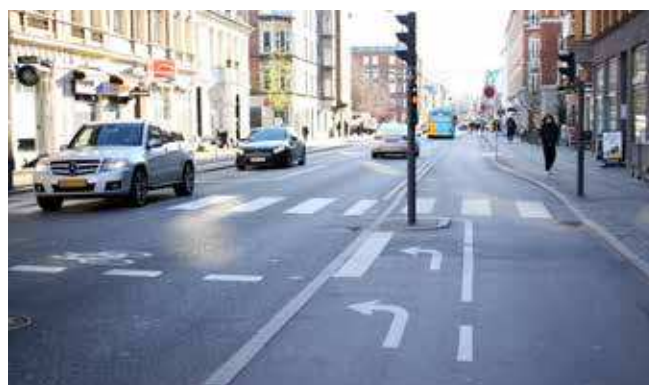
Venstresvingsbane og cykelfelt i T-kryds, Amagerbrogade/Brysselsgade
