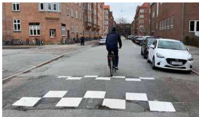
Trapezbump på Ungarnsgade
