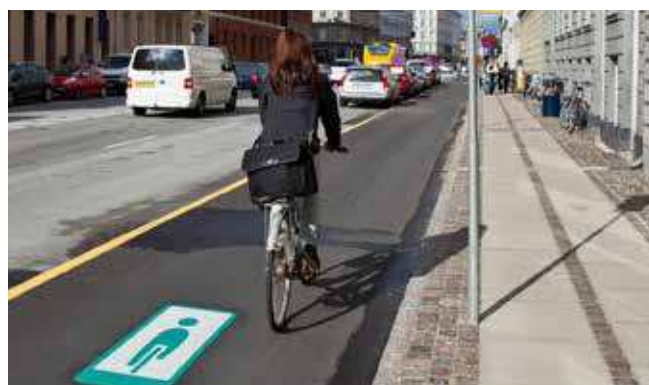
Asfaltbelægning på cykelsti, foto Ursula Bach
