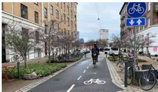
Vejlukning med cykelsluse på Reykjaviksgade
