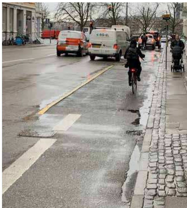
Forstærket cykelbane ved busstoppested på Classensgade
