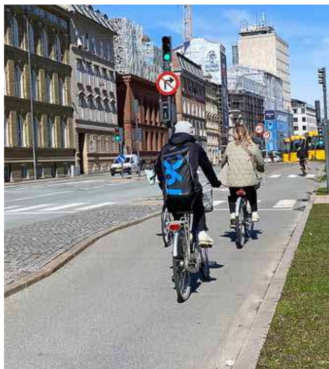
Udvidet cykelsti på Nørre Voldgade
