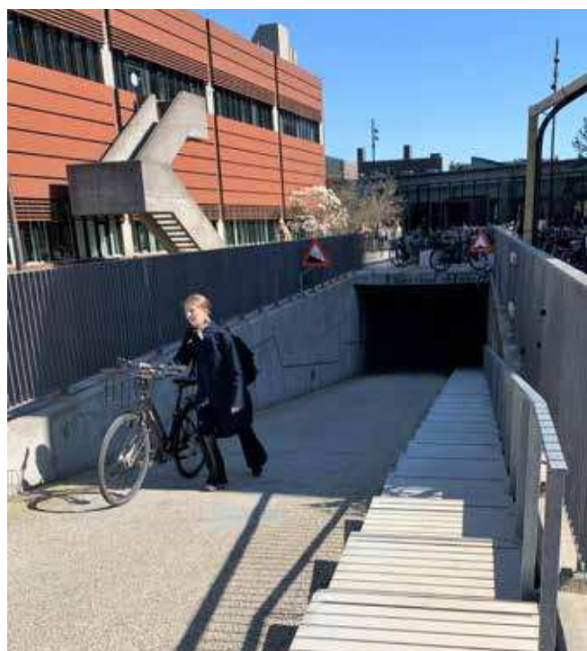
Tilkørsel til cykelkælder ved Panum
