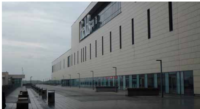
Centergade syd for Field's set fra hovedindgangen ved Ørestads Boulevard. Til venstre ses adgangen fra p-kælderen.
