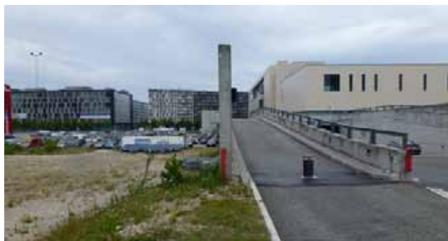
Ove Arups Vej med nedkørsel til p-kælder og rampe til Centergade langs Field's. Område II ligger til venstre for rampen.
