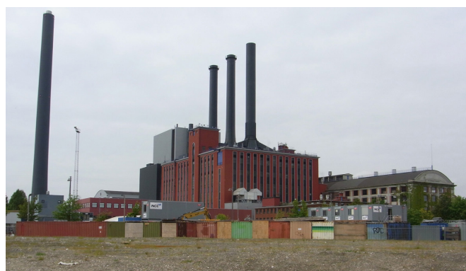
H. C. Ørstedværket set fra øst mod vest. Værket udgør med sin markante arkitektur et væsentligt landmark i planen.
