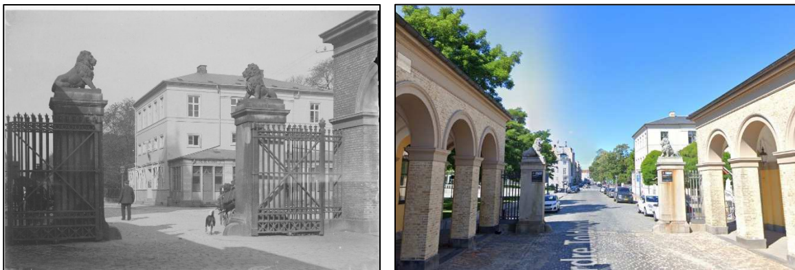
Figur 6.2.1.2 Til venstre ses Løveporten ca. 1900-1910, der tidligere var én af hovedadgangene til Frihavnen. I baggrunden rederiet C.K.Hansens bygning af V. Petersen i baggrunden. Til højre ses området i 2022 (Kilde: Københavns Stadsarkiv, Google street View)
