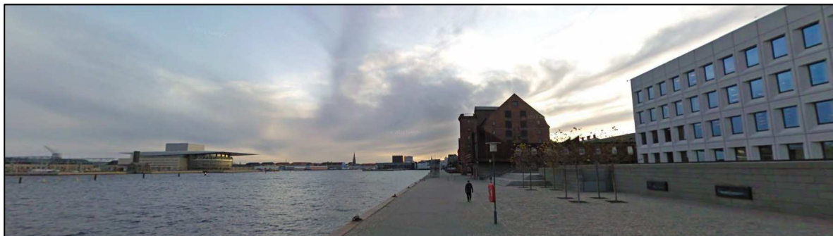
Figur 6.6.1.2 Foto af havnepromenaden fra Esplanaden 50 med Inderhavnen (tv.) og Vestindisk Pakhus (mf.). Byggeriet der nedrives på Amaliegade 44 ses mellem pakhuset og Mærskes hovedsæde (th.) (Kilde: Google Street View).
