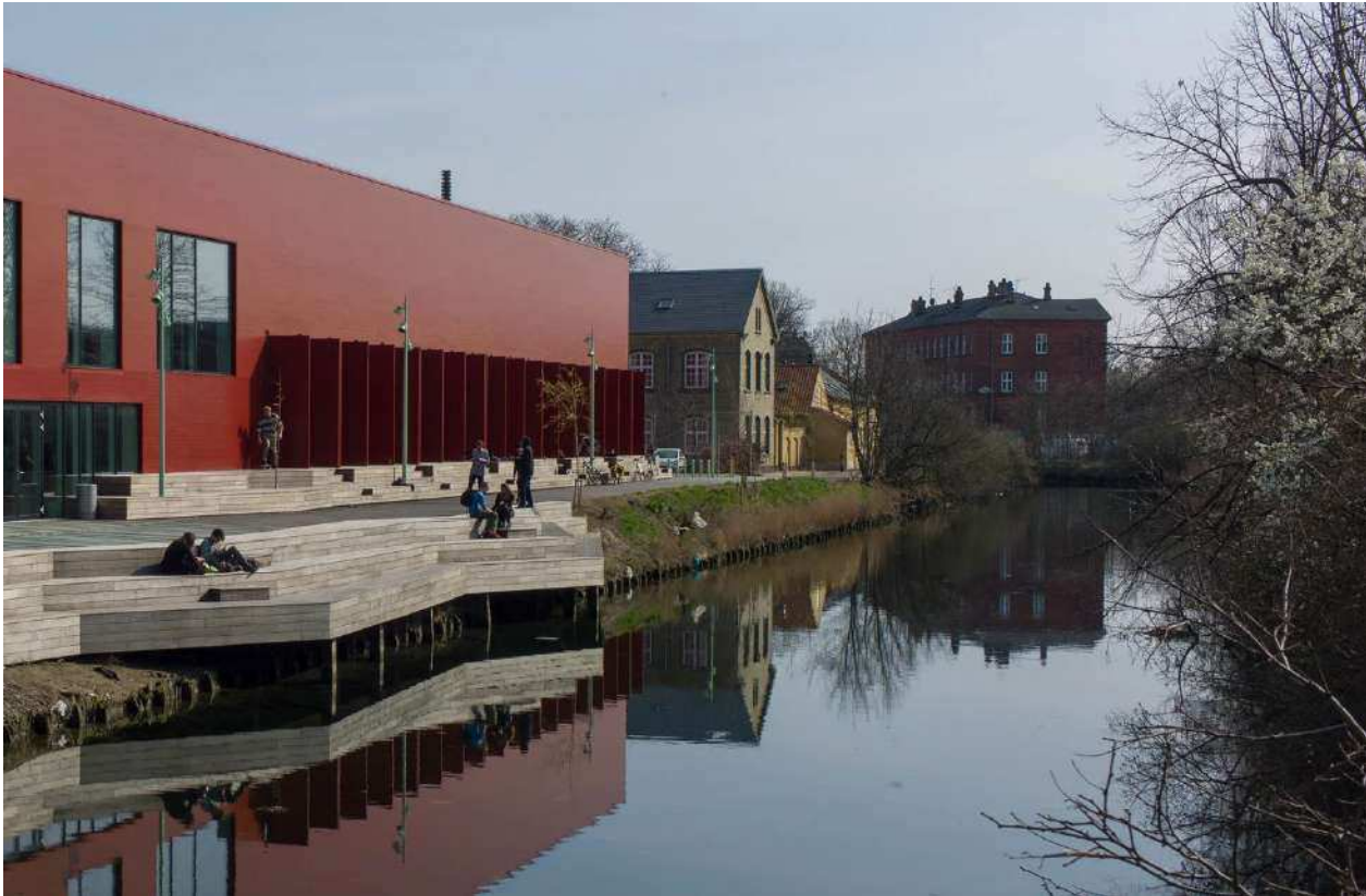
Eksisterende trappeophold ved Hal C
