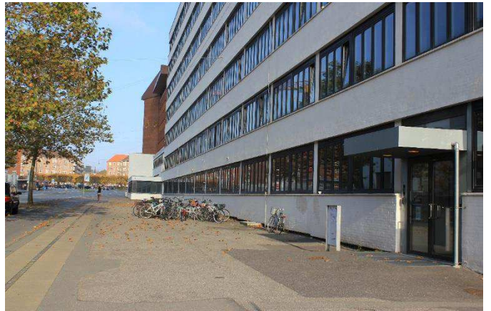
Den kommunale ejendom Ottiliahus, Gammel Køge Landevej 11, der skal renoveres til kontorformål. Arealet foran bygningen trænger også til en opgradering.
