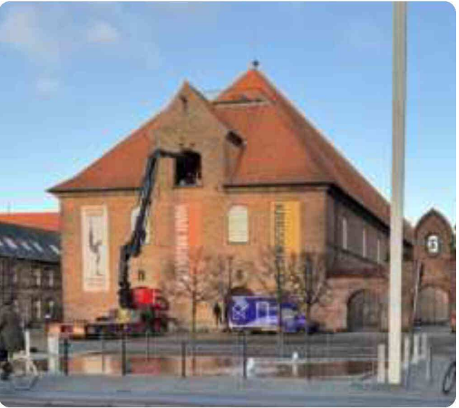
Krigsmuseet (Fredet Bygning / Høj bevaringsværdi, niv. 1) - Museet er en del af Nationalmuseet. Bygningen har hjemme i Christian 4.s gamle tøjhus fra 1604, den ældste bygning på pladsen. (Et tøjhus er et våbenarsenal.) Kanonhallen i bygningen er med sine ca. 160 meter Nordeuropas længste hvælvede hal.
