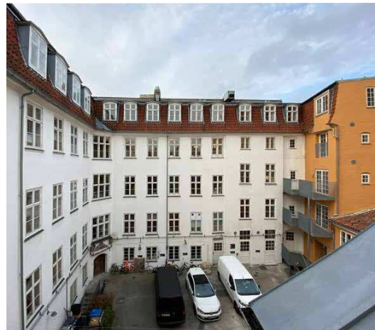
Gårdfacade forhus - set fra sidehus
