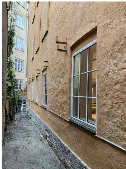
Vinduer på nordfacaden (lukkede fra 1. sal og op)
