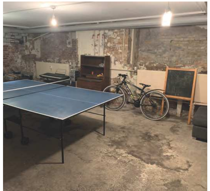
Fugtsikring af kælder
