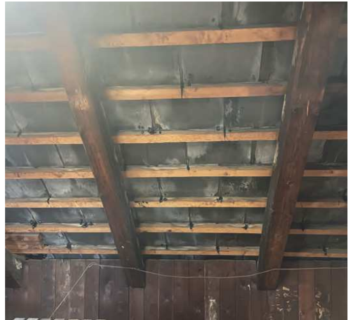
Der efterisoleres og etableres undertag
