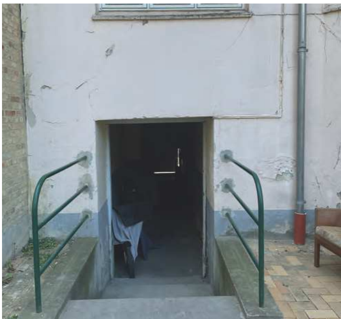
Efterisolering af kælderport mod beboelse, genopretning af gårdfacade
