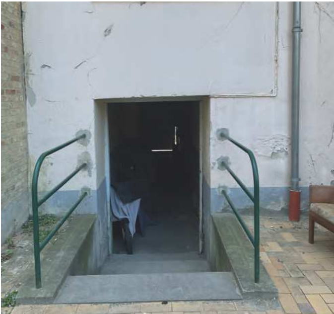
Efterisolering af kælderport, genopretning af gårdfacade
