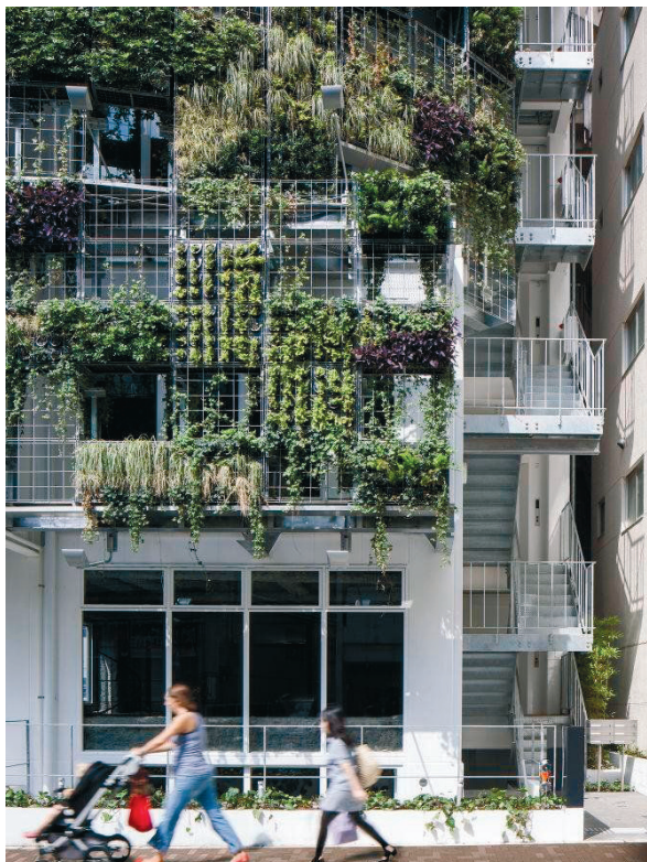
FACADEKOMPLETTERING: Begrønning som kompletterende element udenpå klimaskærm. Her Tokyo.
