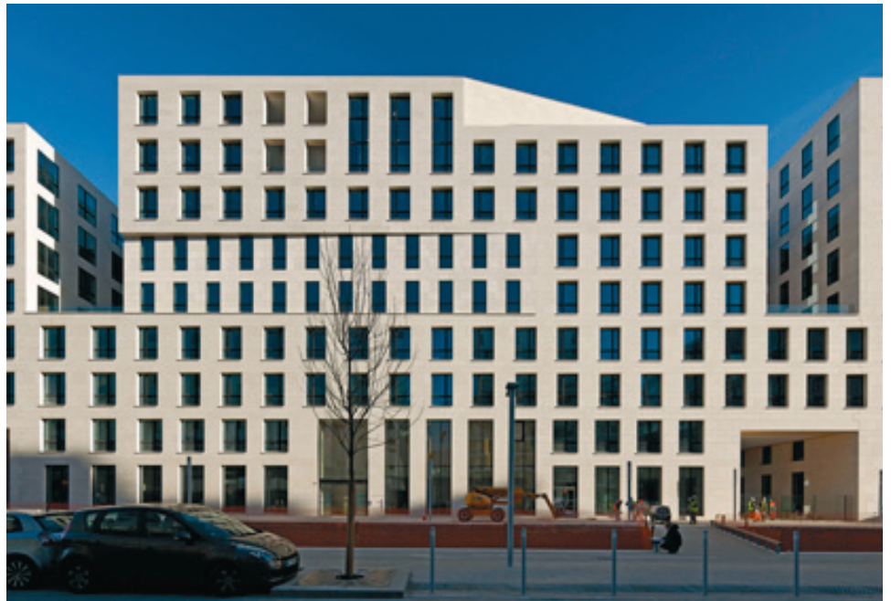
FORSÆTNINGER: Skalering af volumen gennem tilbagetrækning og forskydninger i facadelinien. Her i Paris.
