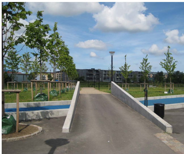
Rampe i Mimersparken i retning mod underføringen
