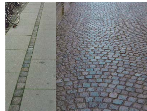
1 Belægninger i beton og chaussésten.
