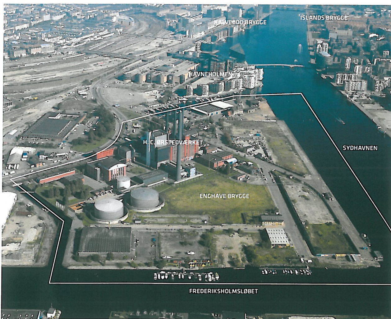
Luftfoto af Enghave Brygge set mod nord. Havneholmen, Fisketorvet, Kalvebod Brygge, banearalerne samt Islands Brygge ses i baggrunden. JW Luftfoto 2011.
