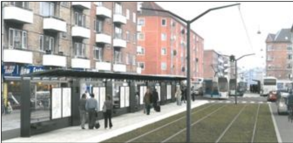
Frederikssundsvej ved Mågevej / Glasvej set i retning mod Nørrebro Station. Letbanetracéet sideforskydes her til venstre i en skarp kurve.
