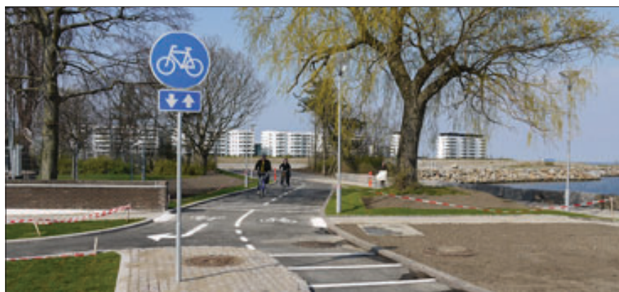
Den nye cykelforbindelse til byggeriet i Tuborg Havn
