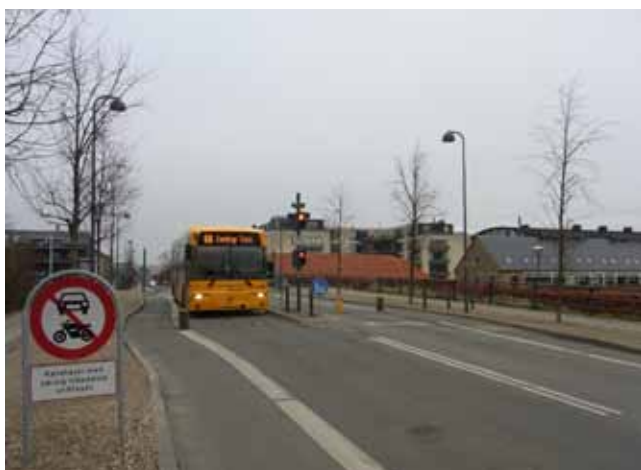
Busslusen der spærrer for gennemkørslen med undtagelse af HT-busser og cyklister.
