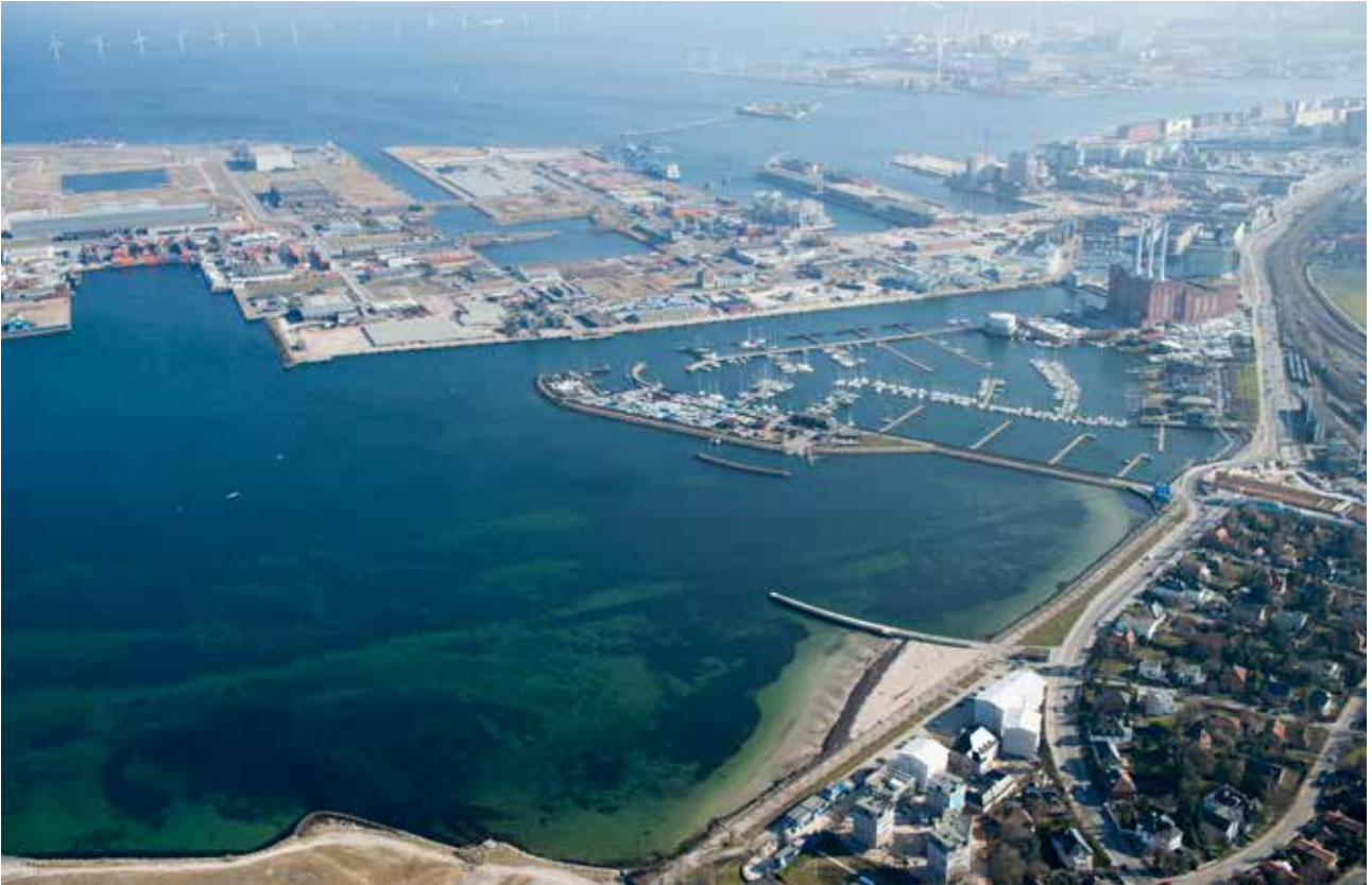
Figur 5.7 Eksisterende forhold i Svanemøllebugten. Luftfotoet er taget mod sydøst.
