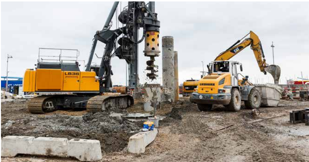
Maskiner til brug under anlægsarbejdet. Foto: John Ehbrecht, Lejrefoto.
