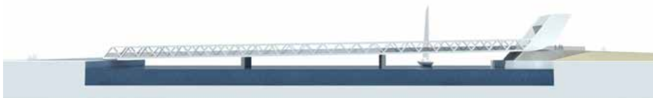
Figur 2.8 Klappbroen er ca. 130 meter lang og ca. 5 meter høj.
