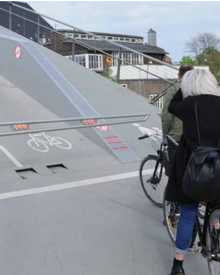
Trangravsbroen i København har to oplukkelige broklapper. Foto: Thomas Knudsø Damm.
