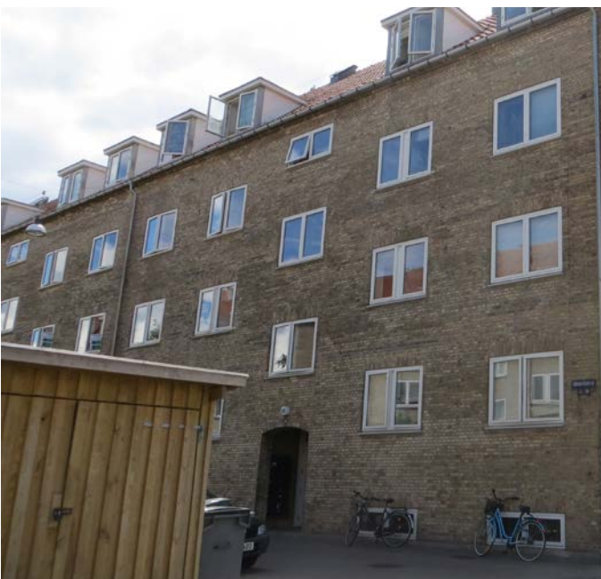
Facader af Stradellasvej og i spejlingen Tartinisvej
