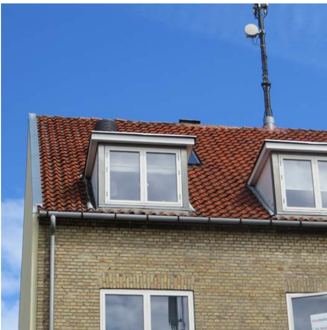
Isolering af skråvægge og tagloft
