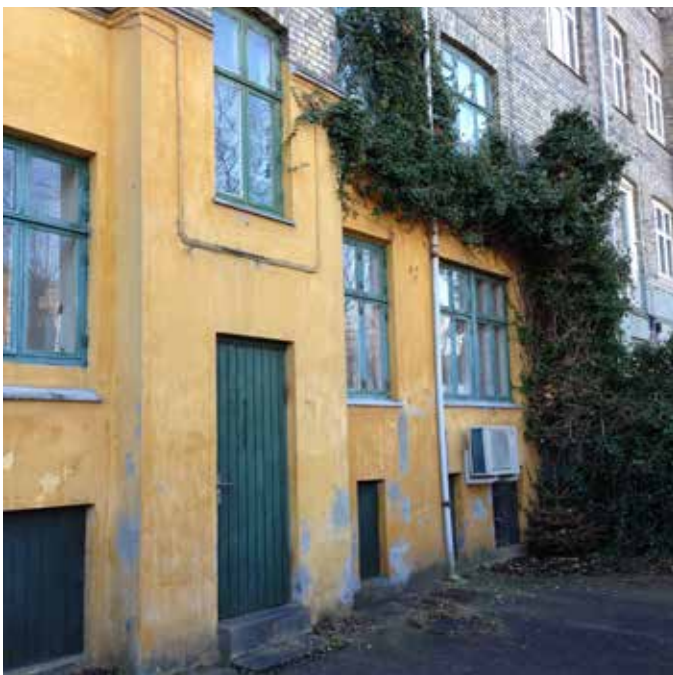
Gårdfacaden instandsættes og der laves omfangsdræn
