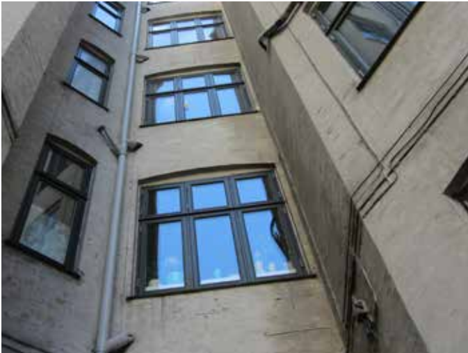
Utætte termoruder udskiftes til nye energi og støjvinduer
