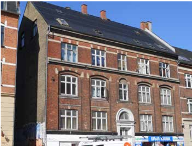
Gavl efterisoleres udvendigt og facader indvendigt
