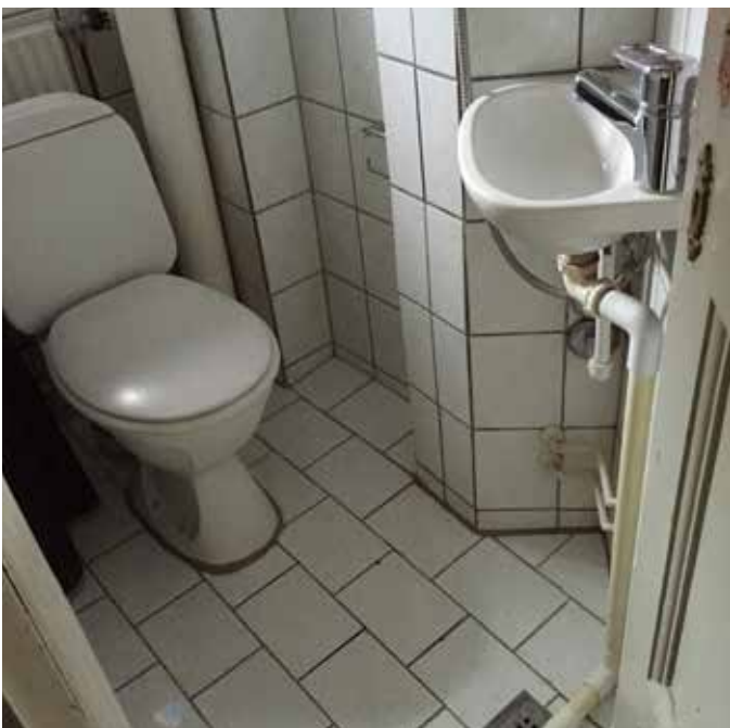
Toiletter på bagtrappen lægges ind i lejlighederne
