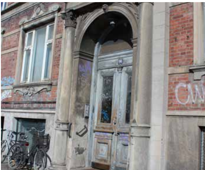
Døre og facader idstandsættes
