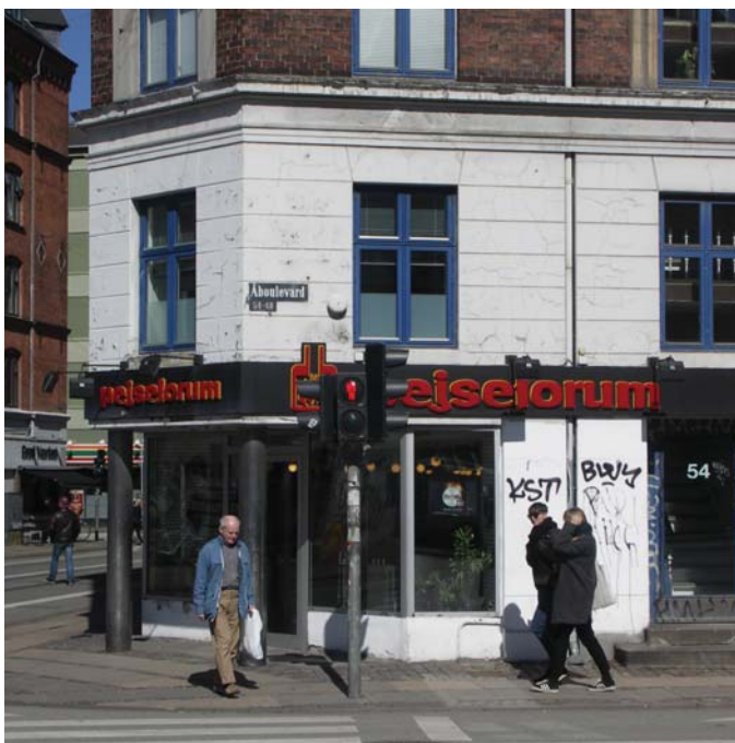
Vinduer udskiftes og underfacade renoveres
