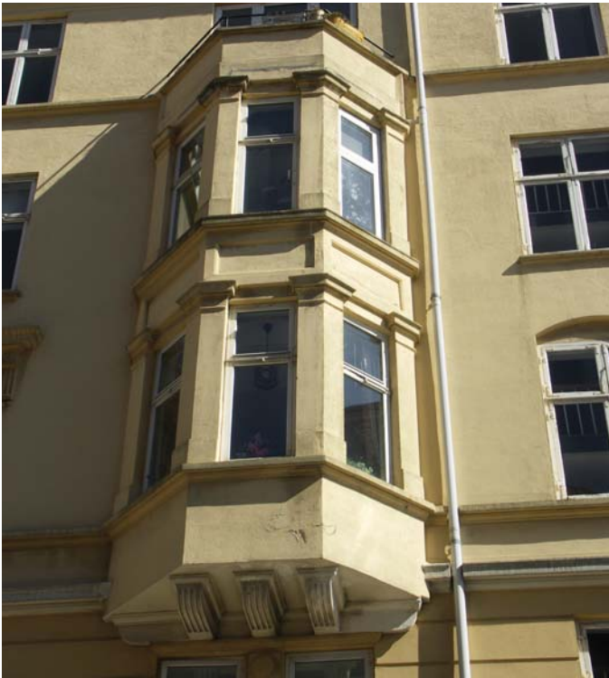
Facade istandsættes og vinduer udskiftes
