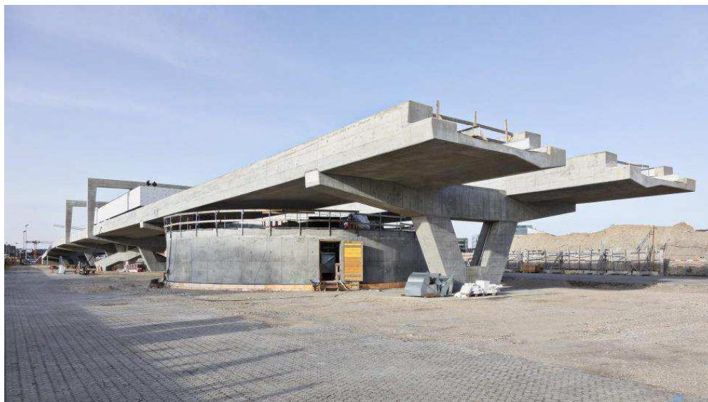
Figur 4: Højbanekonstruktionen på M4 til Orientkaj af M4 i Nordhavn
