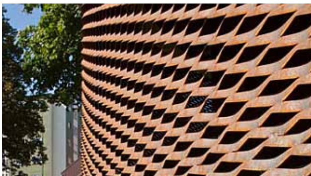
Referencefoto. For at give facaderne struktur tænkes cortenstål paneler udført som strækmetal.
