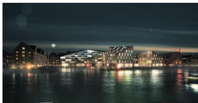
Nyt byggeri på Krøyers Plads set fra Havnegade, som det kan se ud en majnat
