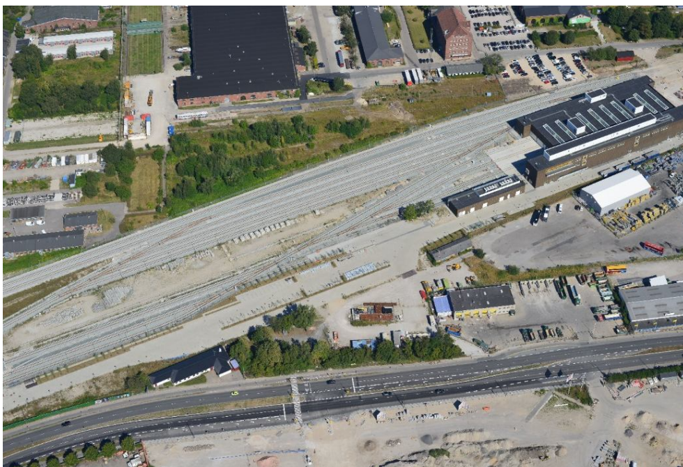
Figur 18: Kontrol- og vedligeholdelsescenter ved Vasbygade gør det svært at etablere sammenhængende by i perspektivområdet Godsbaneterrænet, der ligger mellem Vasbygade og baneterrænet ved Vesterbro.
