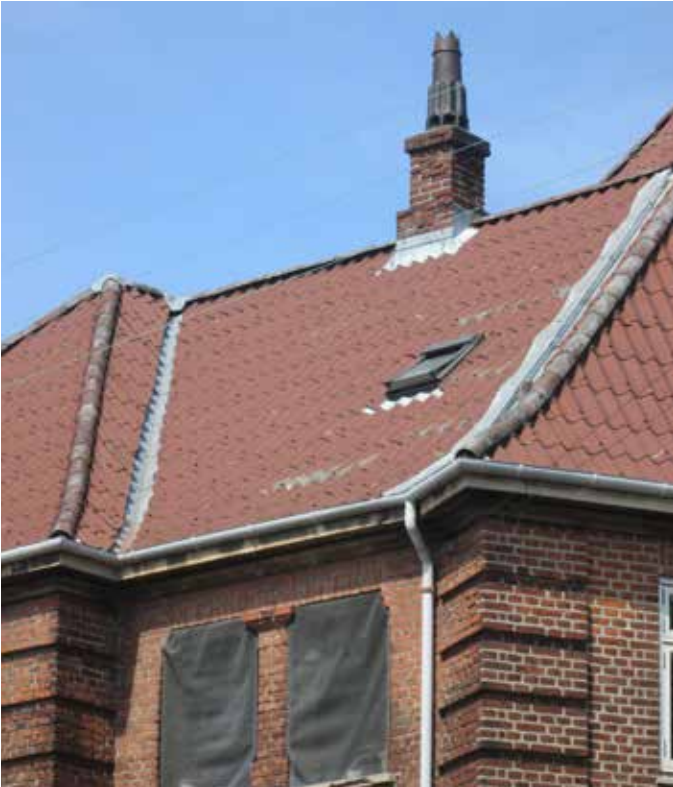
Tagbelægning udskiftes, derudover isoleres tag og kviste.
