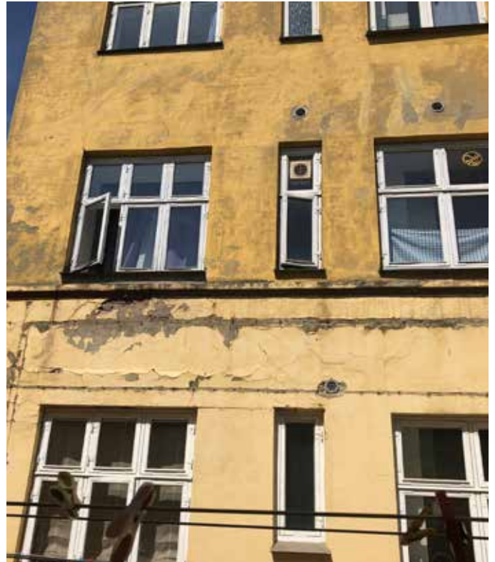
Gårdfacade er i meget dårlig forfatning og isoleres udvendigt. Derudover skiftes taget og vinduerne til energirigtige vinduer.
