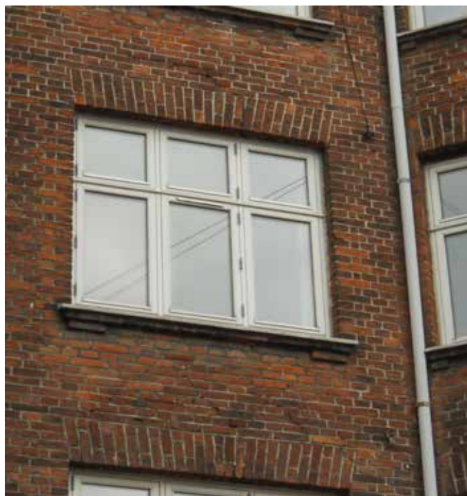
Facader renses og istandsættes/tættes ved omfugning.
