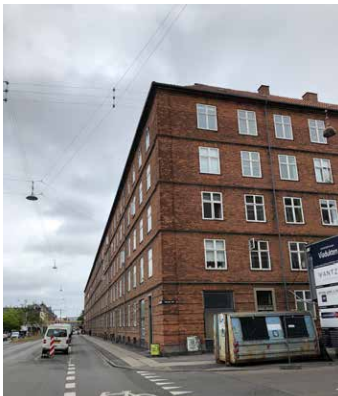
Vinduer uskiftes til støjreducerende og energibesparende vinduer.
