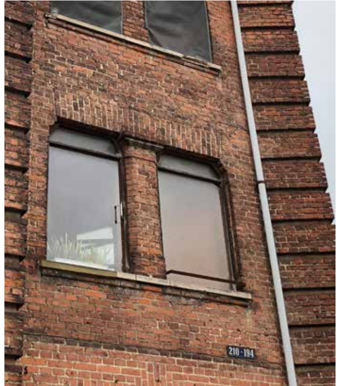
Facader omfuges og sokkel istandsættes.
