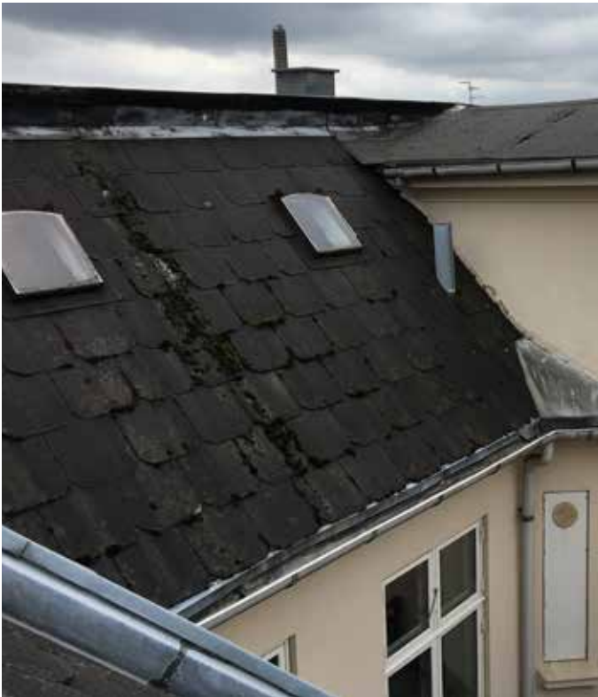
Taget er klar til udskiftning, og der isoleres mod beboelse
