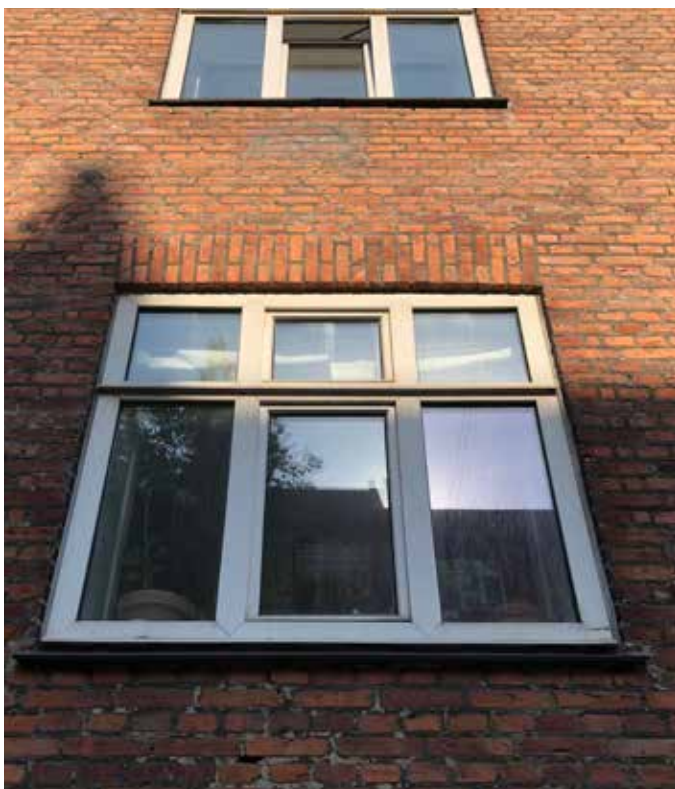
Utætte plastikvinduer udskiftes med støjrducerende træ/ træ-alu vinduer mod hhv gade/ gård. Alle sålbænke udskiftes.
