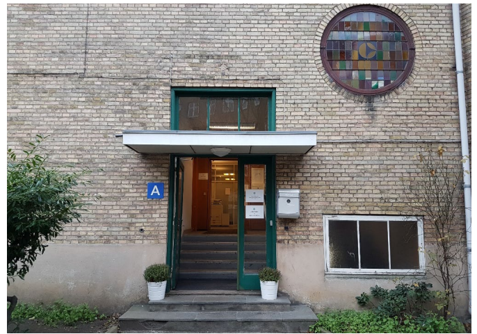
Hovedindgang med originalt rundt glasmosaikvindue med Electrolux-logo og originalt kældervindue i træ med tredelt opsporsning.
