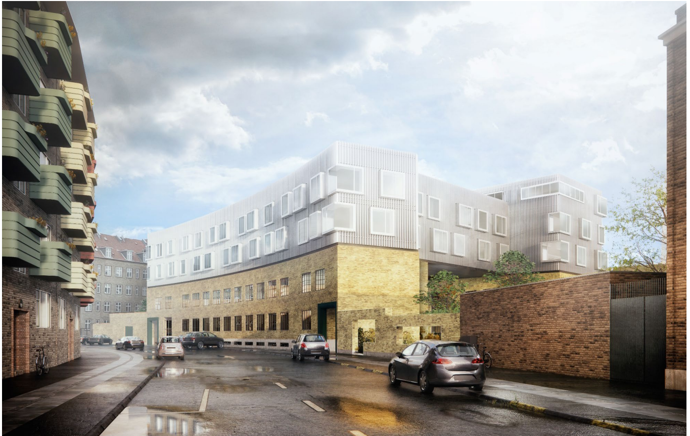
Visualisering af nybyggeri, som det vil blive oplevet, set fra Hermodsgade. Facader er beklædt med lodrette, rektangulære lameller. Lamelbeklædning er vist som en signatur. Illustration: Steen Palsbøll Arkitekter m.a.a.
