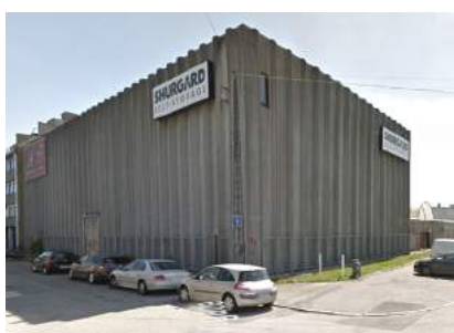
MATRIKEL 437 Byggeri i 3 etager. Indeholder opbevaringsrum for Shurgard.
