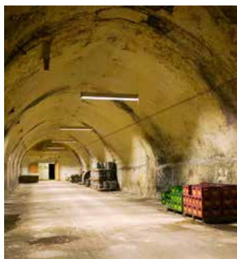
Kælderen under Rød Lagerbygning.
