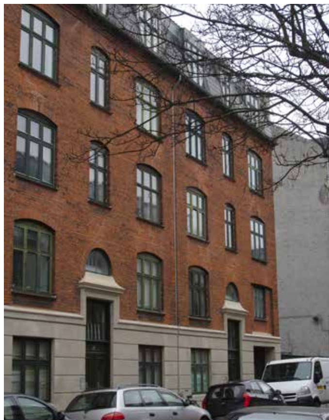
Facade mod Falkevej istandsættes og tættes
