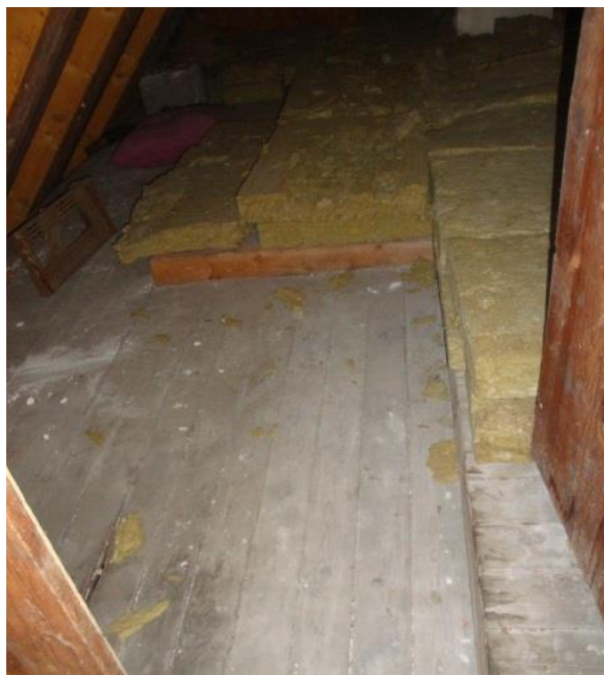
Etageadskillelsen på loftet efterisoleres
