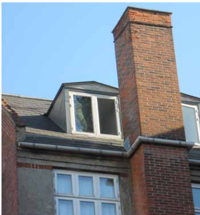
Tag og kviste udskiftes og isoleres
