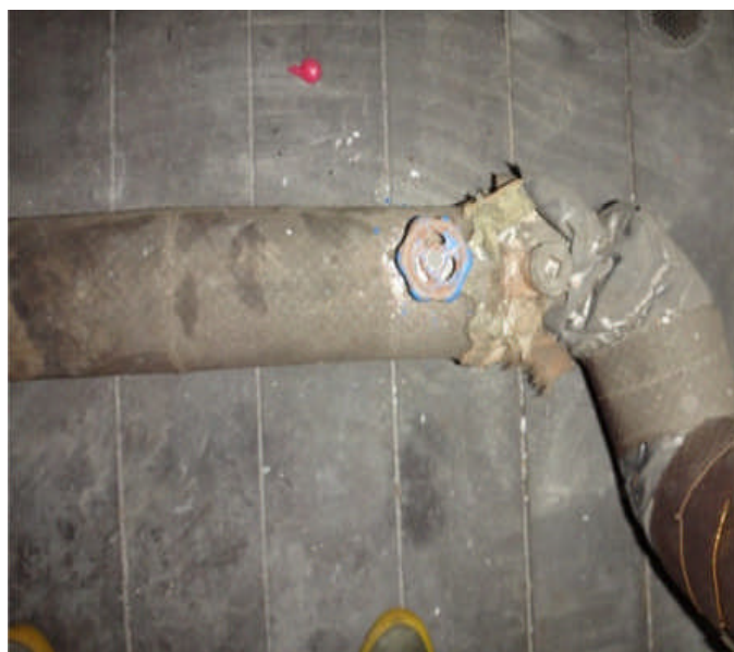
Vandinstallationer udskiftes til nye
