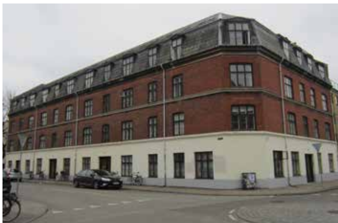
Forhusets facader mod Hejrevej og Ørnevej
