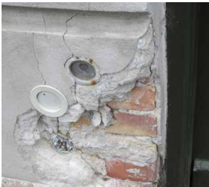
Facader istandsættes og tættes
