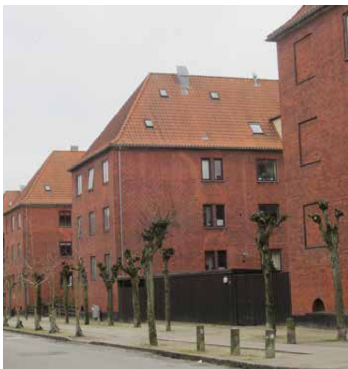
Facader mod Rørsangervej
