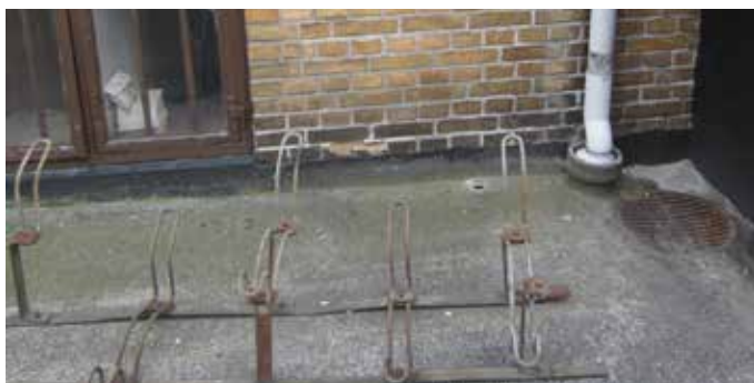
Fundament på forhus fugtsikres og isoleres
