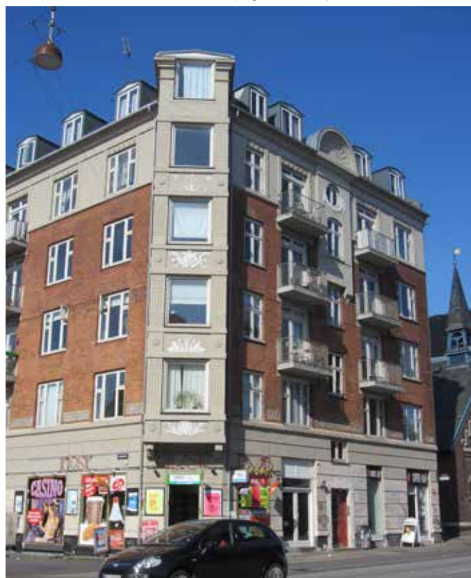
Facader mod Frederikssundsvej og Lærkevej
