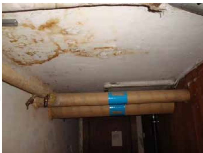
Etageskillemur mod loft og kælder isoleres
