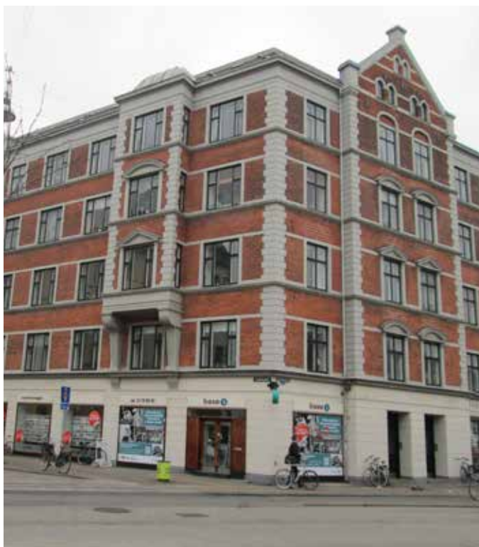
Facader mod Sønder Boulevard og Dybbølsgade
