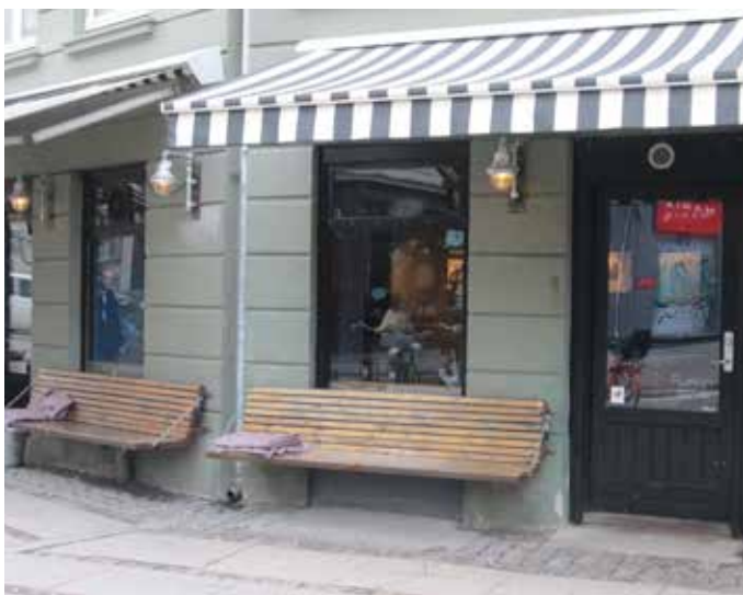
Vinduer udskiftes til lavenergivinduer
