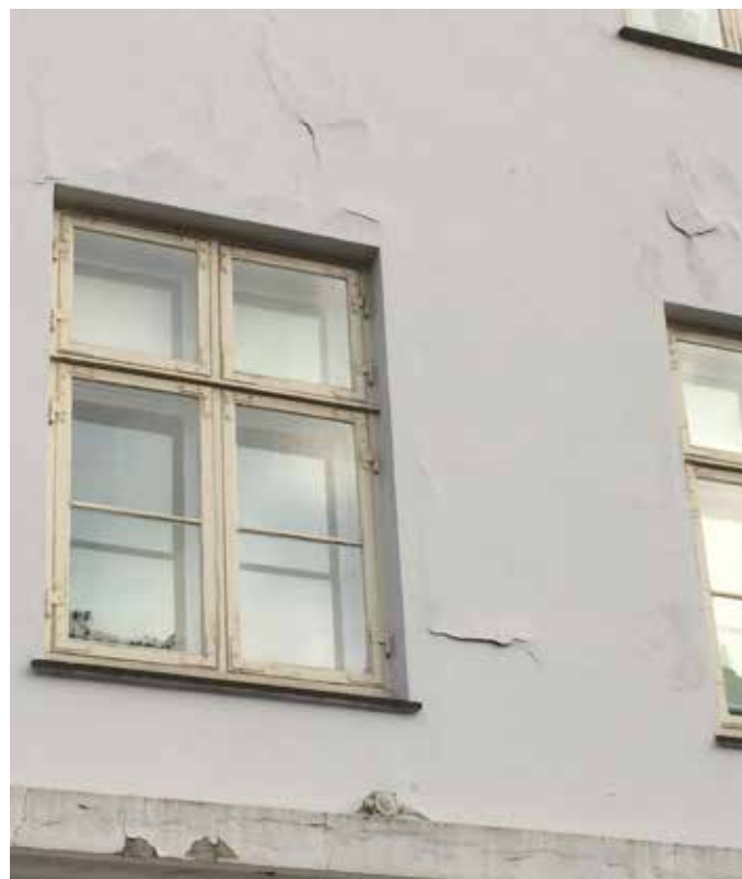
Pudsede facadefelter med afskallinger istandsættes
