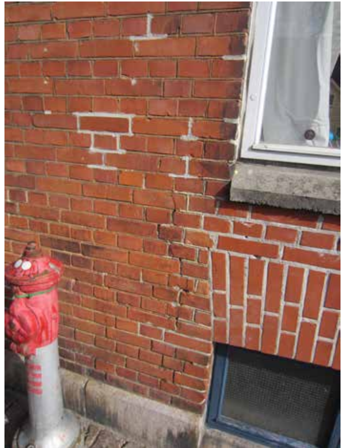
Revner i murværk tætnes og istandsættes
