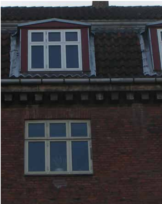
Reparation af tag og isolering
