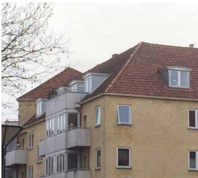
Tag udskiftes og isoleres. Karnapper isoleres udvendigt
