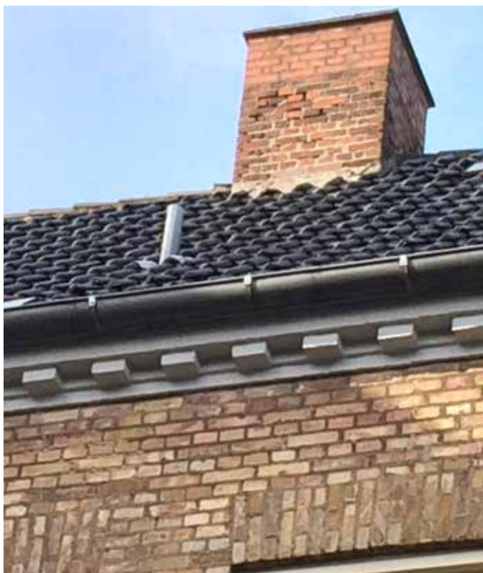
Nedslidt tegltag udskiftes til nyt med isolering
