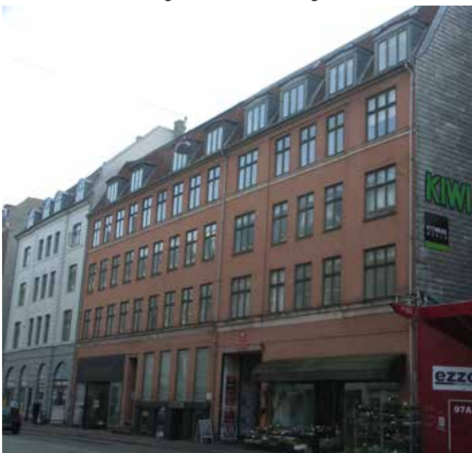
Gårdfacade er nedslidt og efterisoleres udvendigt Facade mod Vesterbrogade istandsættes og efterisoleres
