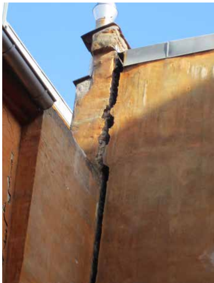
Tydelig revne mellem forhus og toiletpåbygning udbedres
