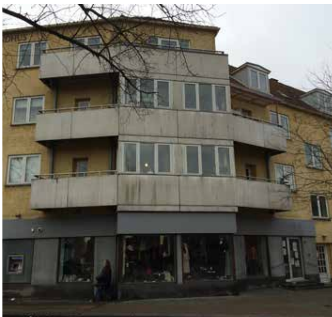
Facade mod Mozarts Plads
