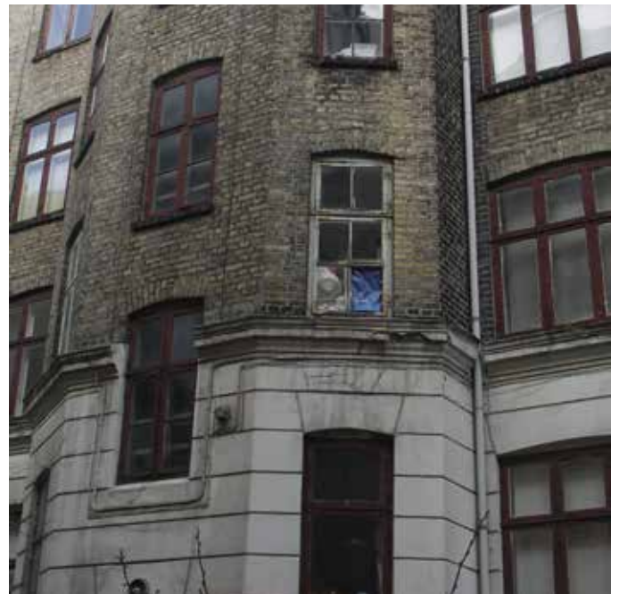
Nedslidte vinduer mod gård udskiftes
