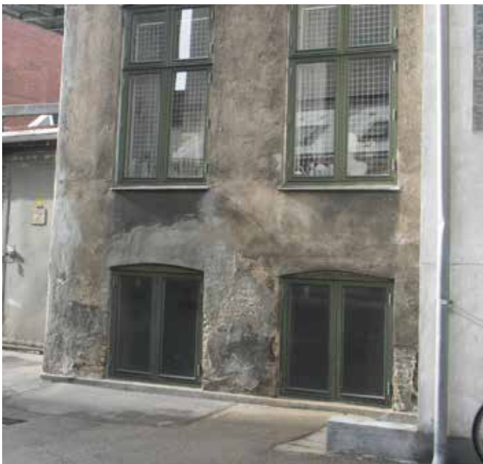
Gårdfacade er nedslidt og efterisoleres udvendigt Facade mod Vesterbrogade istandsættes og efterisoleres
