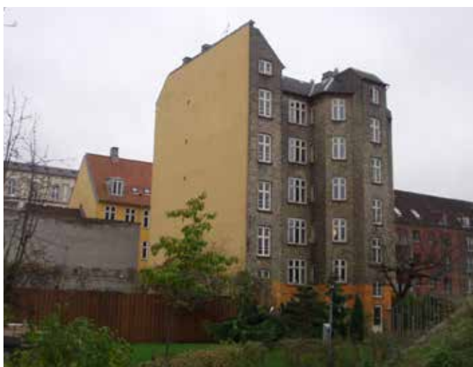
Baghuset får udskiftet vinduer og nyt tag
