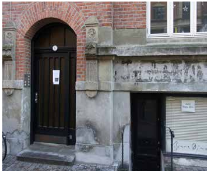
Underfacade, tydeligt påvirket af fugt, istandsættes
