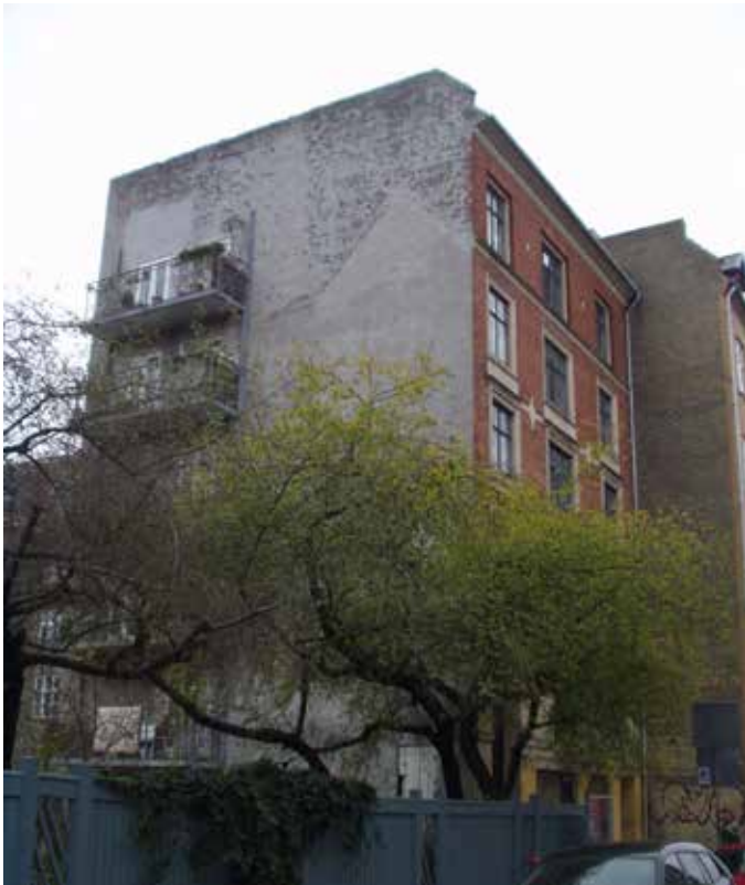
Gavl mod gårdside efterisoleres
