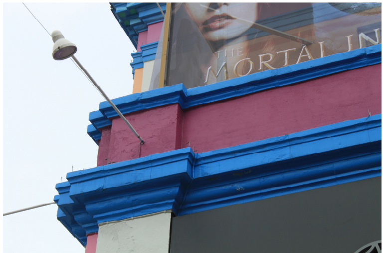
Belysningsstander på facade
