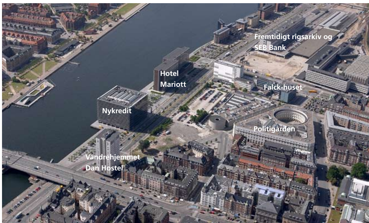
Luftfoto af lokalplanområdet omgivet af ældre karrébebyggelse, og større eksisterende og fremtidige bygningsvolumener.
