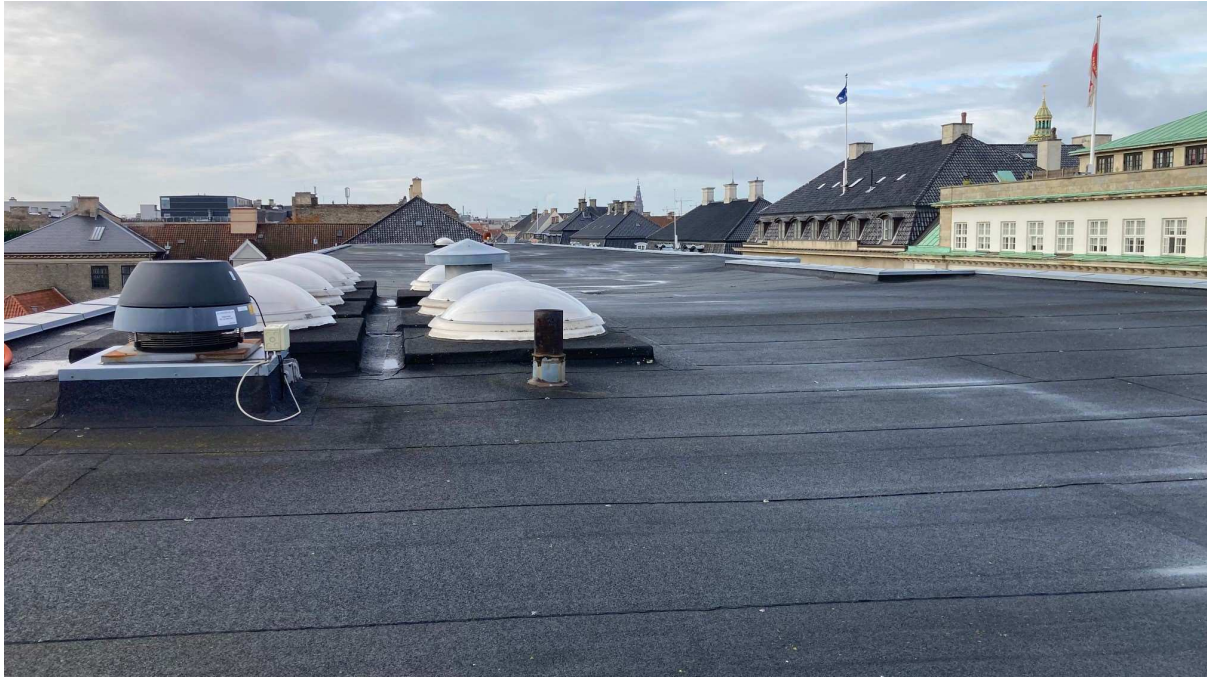
Figur 3 – Tagfladen på den vestlige bygning. Som øvrige tagflader belagt med tagpap uden huller eller sprækker med adgang for flagermus.
