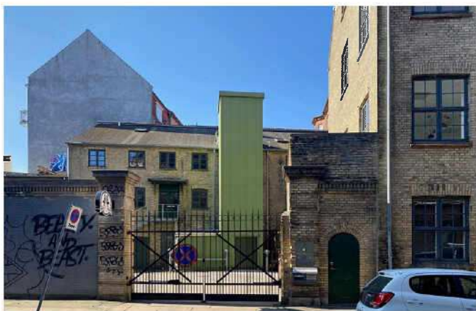
Kig fra Hannovergade mod indgangsparti.
