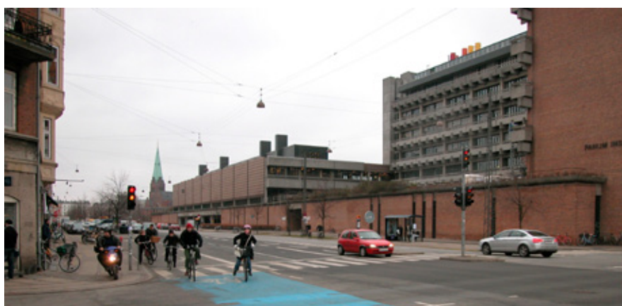
Et kig hen ad Blegdamsvej. Den lave kantinebygning i midten af billedet forventes at skulle rives ned i forbindelse med det aktuelle projekt.
