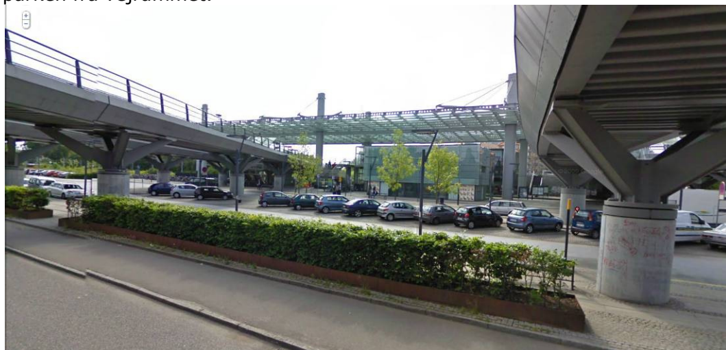
Figur 8: Flintholm St. som indslag i parken. Hække afgrænser park og station mod vejen. Stationsbygning og overdækning danner baggrund for byrummet set fra Grøndals Parkvej
