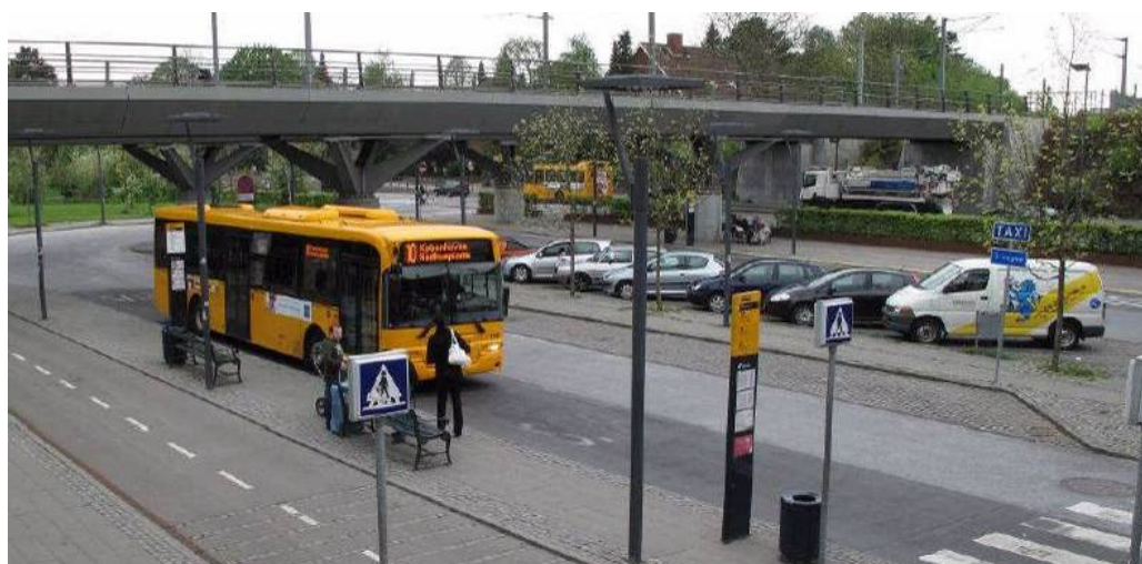
Figur 9: Eksisterende byrum ved Flintholm Station.
