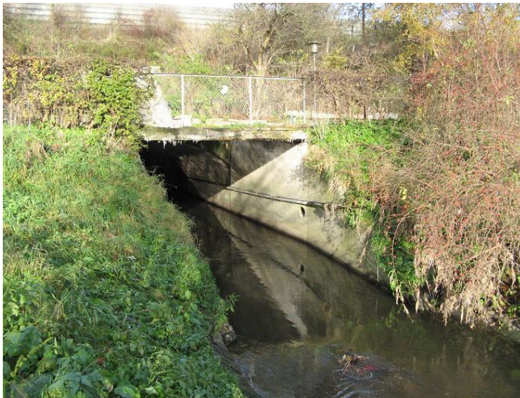
Figur 6-18 Harrestrup Å ved krydsning med jernbanen. Her kan der evt. etableres flydebanketter til faunaen.
